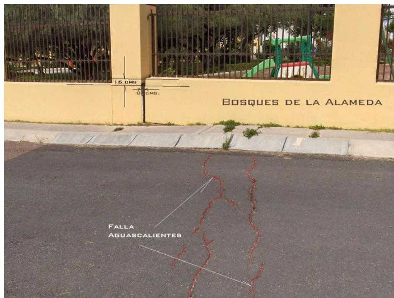
**Figura 30.** Barda del Fraccionamiento “Bosques de la Alameda” que se construyó en el 2006, que desde entonces ha sufrido asentamientos de 0.02 mts. anuales y desplazamientos horizontales de 0.01 mts. por efectos de la “Falla Aguascalientes”.
