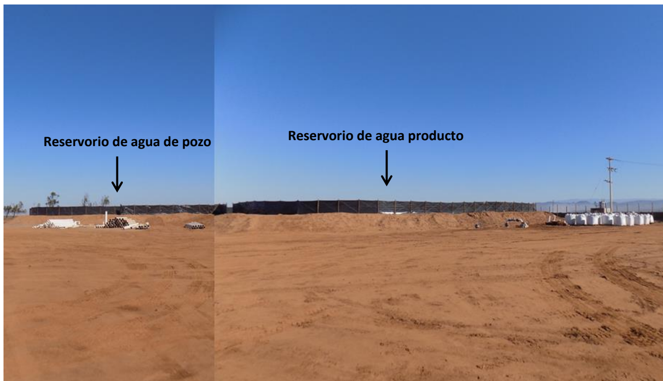
Foto 7. Reservorio de agua de pozo y de agua producto con capacidad de 2000 m 3 y 5000 m 3 respectivamente.
