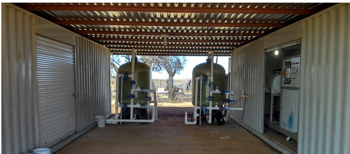
Foto 3. Filtros multimedia, utilizados para la primera etapa de filtración donde se retiran sólidos y partículas.
