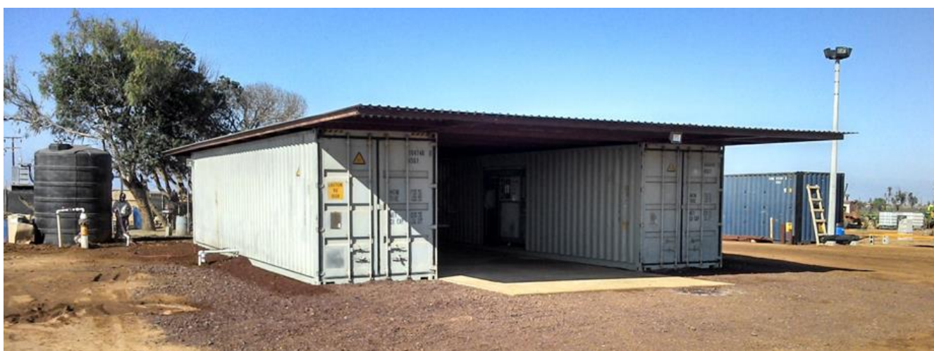
Foto 2. Planta desalinizadora, integrada por dos contenedores que en su interior contienen un módulo de desalación cada uno.
