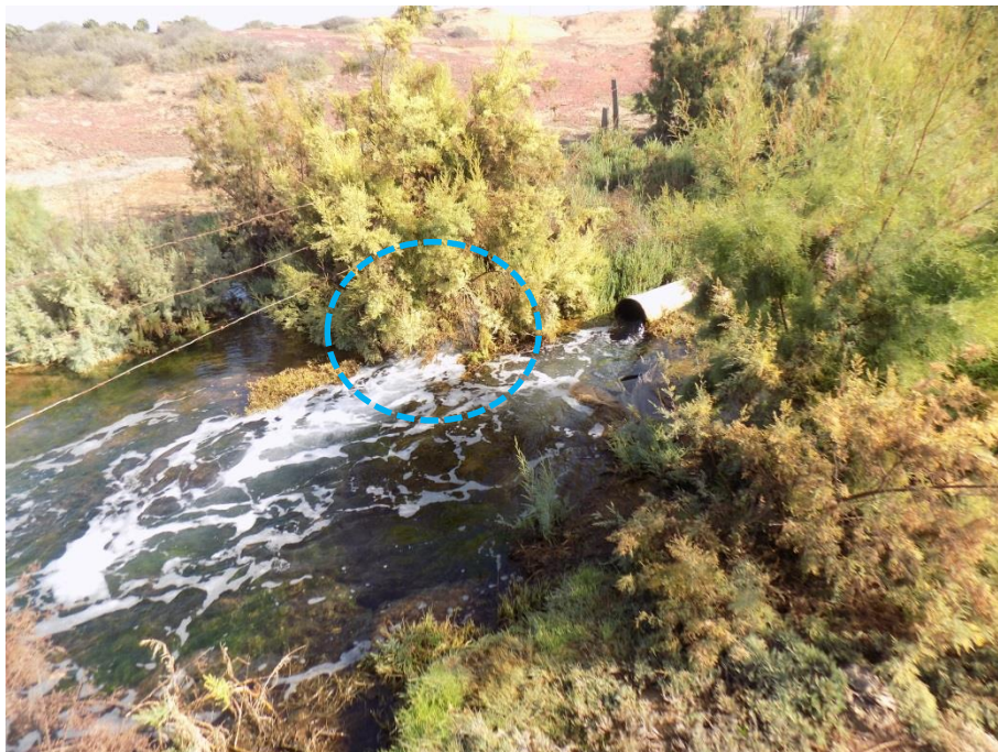
Foto 17. Vista del punto de descarga propuesto. Se aprecia una tubería de descarga (circulo punteado azul).
