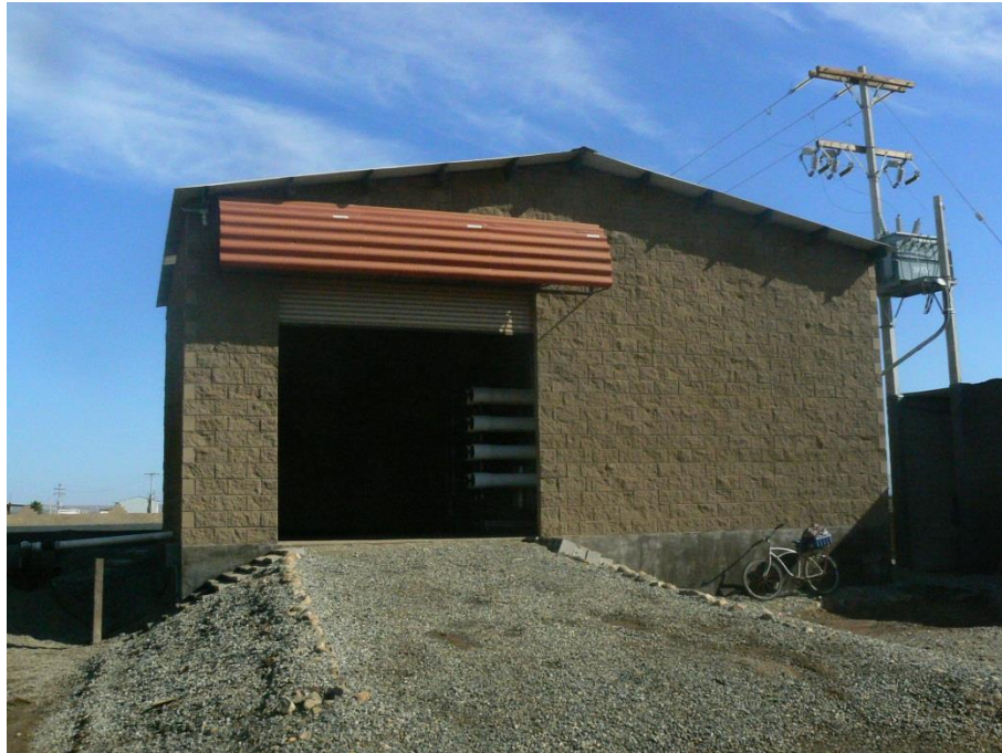
Foto 1. Vista general de la nave que guarda el sistema de osmosis inversa de la planta desaladora.
