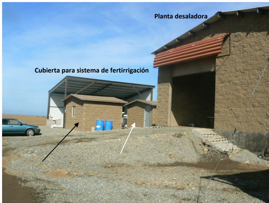
Foto 8. Vista general donde se observa el almacén para productos (flecha blanca), el cuarto de máquinas (flecha negra), la cubierta para el sistema de fertirrigación y la nave que alberga la el sistema de osmosis inversa.
