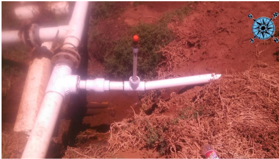
Foto 12. Punto donde se realizó la conexión con la tubería propiedad de la empresa , para conducir el agua de rechazo.
