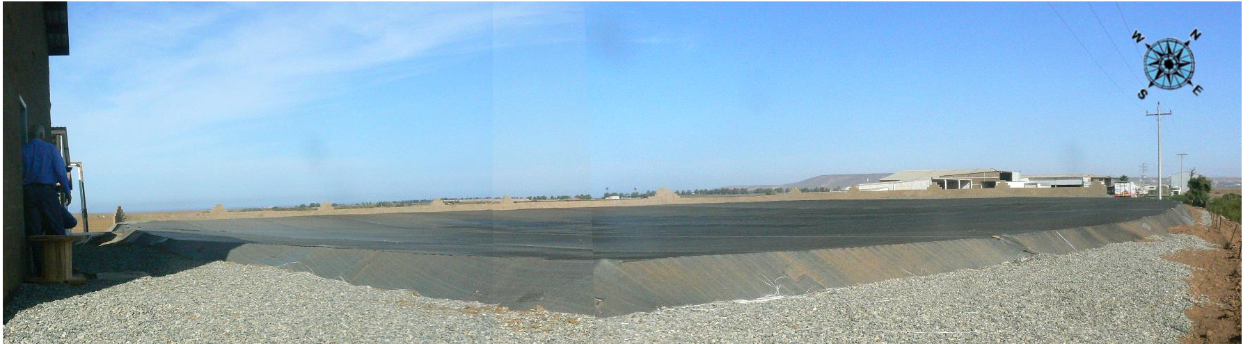
Foto 5. Vista panorámica del reservorio de agua desalinizada de 50mts x 50mts con capacidad de 10,000 m 3 .
