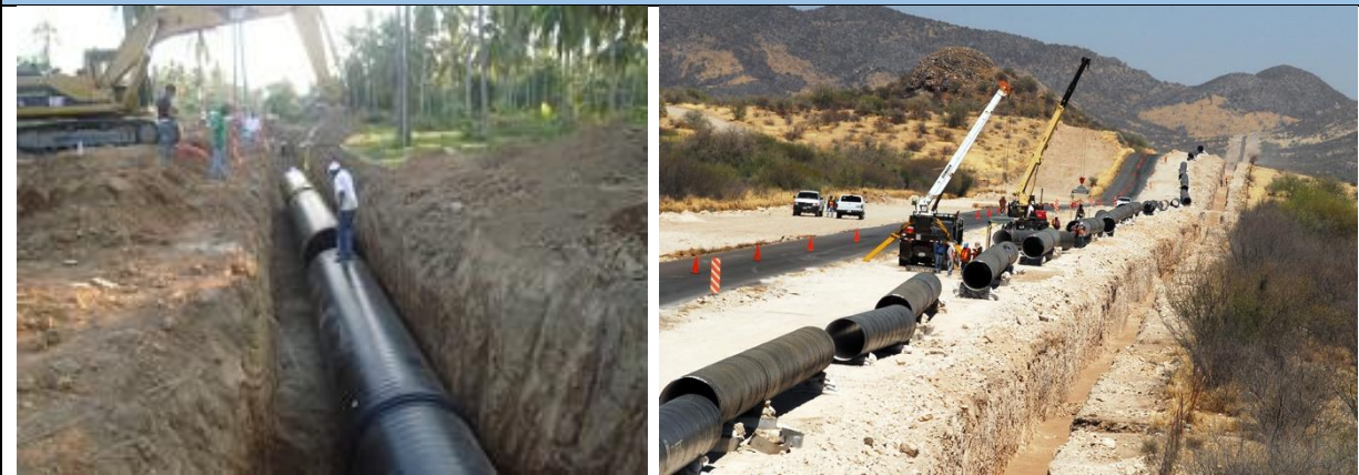
Figura II.VI-6. Imágenes de instalación de línea de conducción
