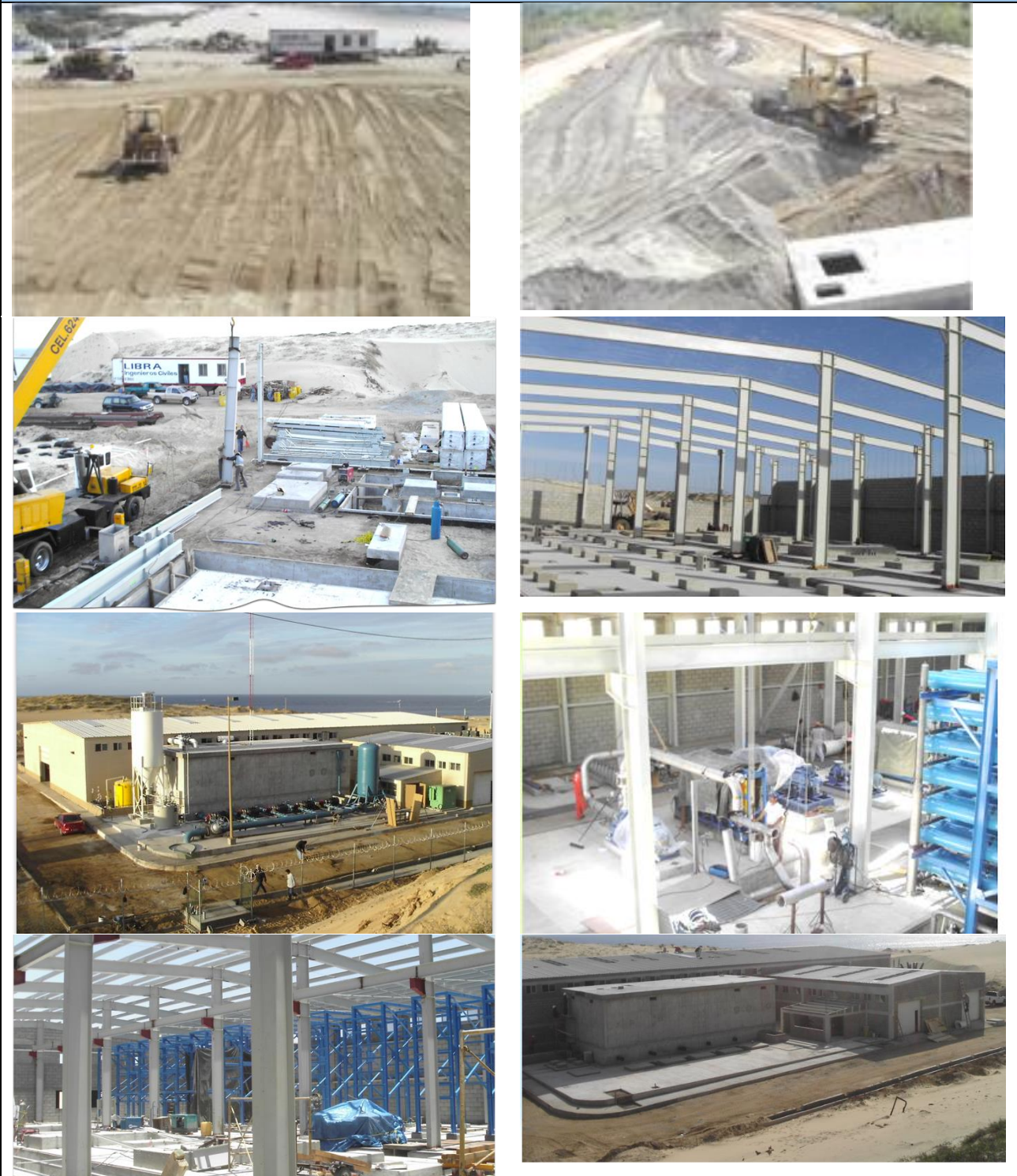
Figura II.VI-4. Imágenes de construcción de plantas desaladoras
