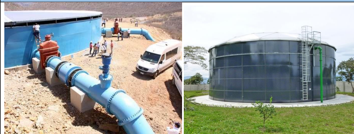
Figura II.VI-7. Imágenes de tanques similares
