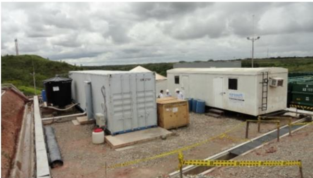
Figura II.V-1. Imágenes de preparación para obras
