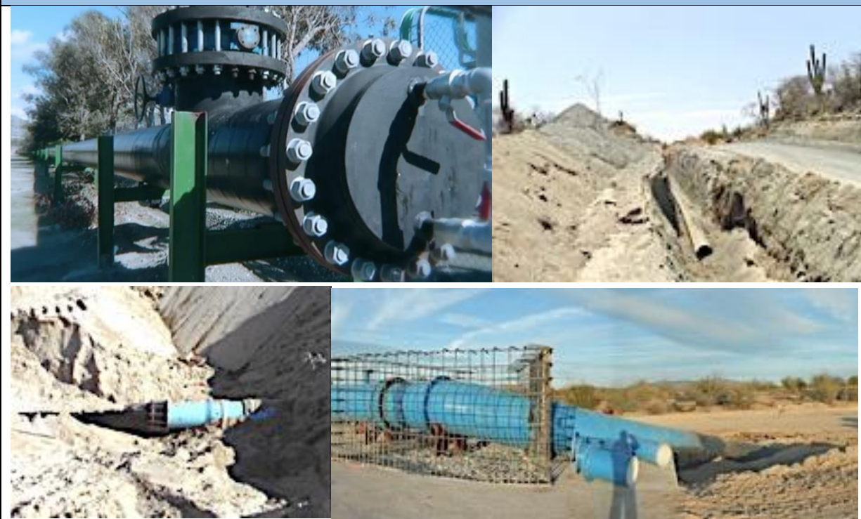
Figura II.VI-3. Imágenes de instalaciones de líneas de conducción
