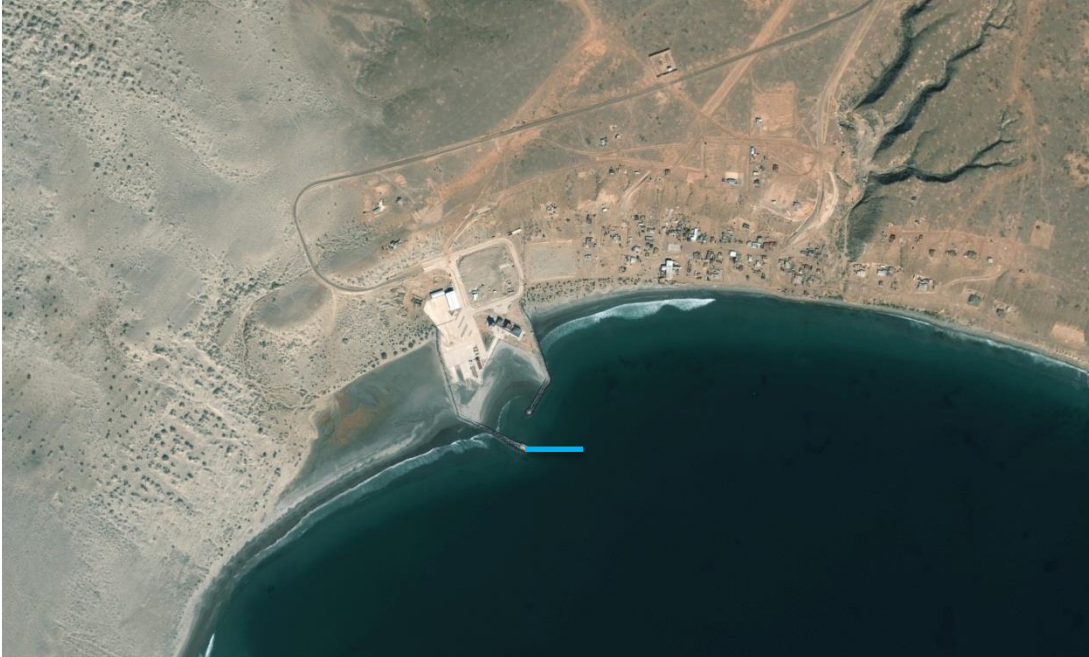
Ilustración 9. Construcción de la prolongación de la escollera oeste en la segunda fase.
