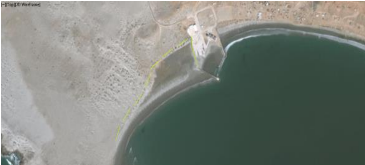
Ilustración 17. Posición del geotextil para retención del transporte eólico de arena.
