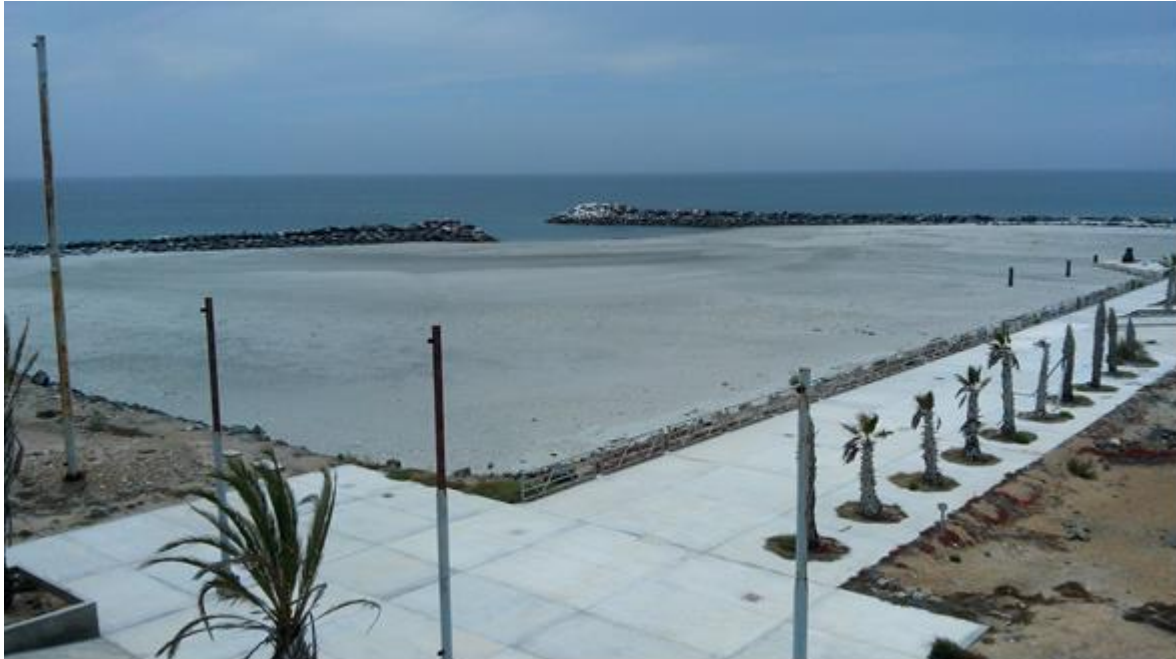
Ilustración 15. Zona de dragado/excavación en zona de dársena de la Escala Náutica.
