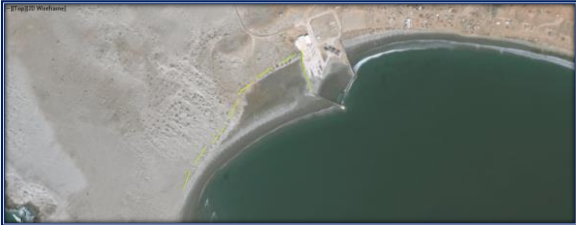
Ilustración 92. Posición del geotextil para retención del transporte eólico de arena.
