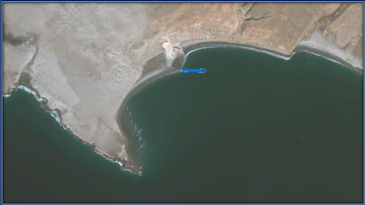
Ilustración 88. Construcción de la prolongación de la escollera oeste en la segunda fase.
