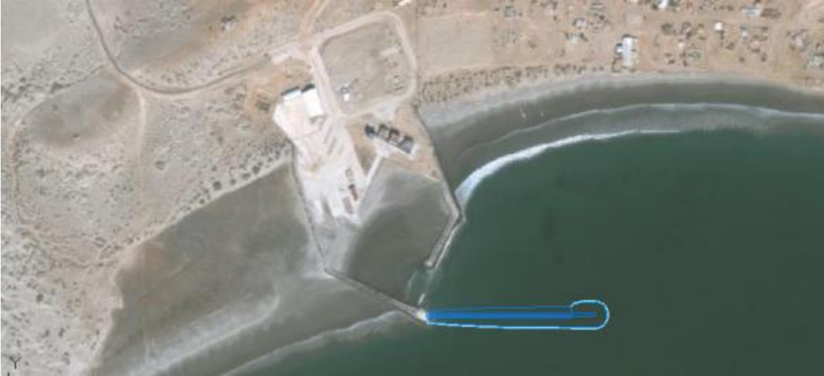
Ilustración 10. Prolongación de la escollera oeste. Longitud 265 metros.
