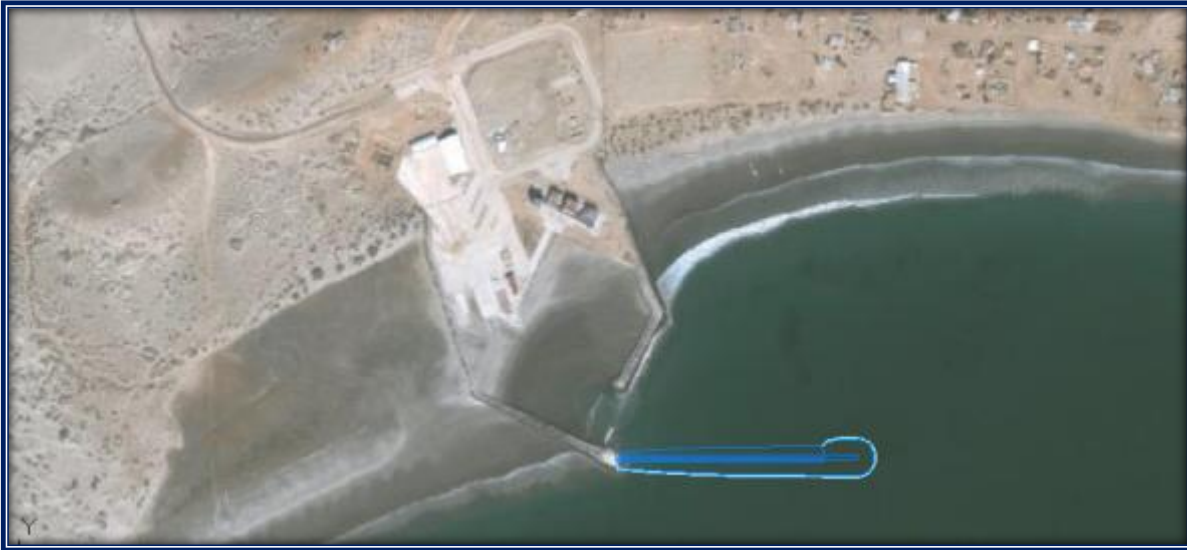
Ilustración 89. Prolongación de la escollera oeste. Longitud 265 metros.
