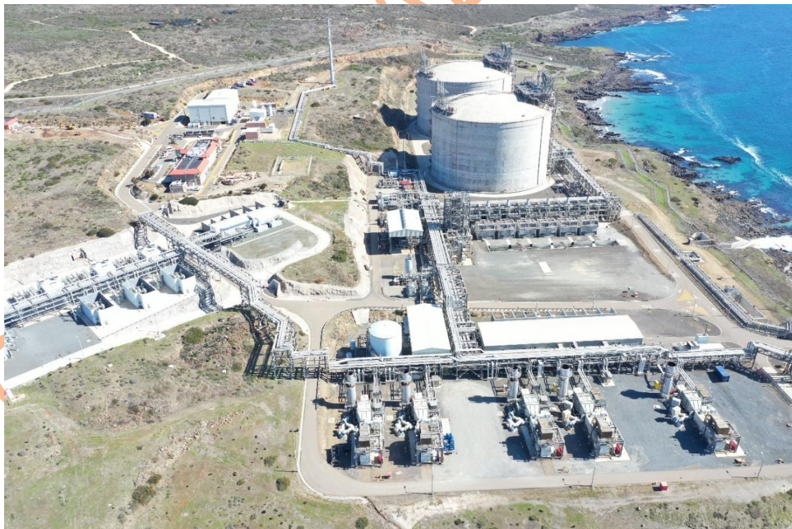
Imagen II.51. Al interior del área que forma parte de los terrenos de Energía Costa Azul se encuentra la subestación La Jovita propiedad de Comisión Federal de Electricidad (CFE) y la terminal existente ECA.
