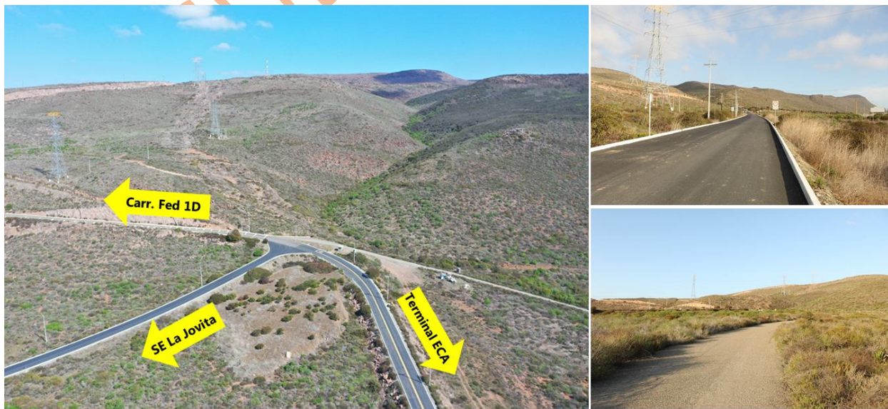
Imagen II.58. Vías de accesos existentes al AP.
