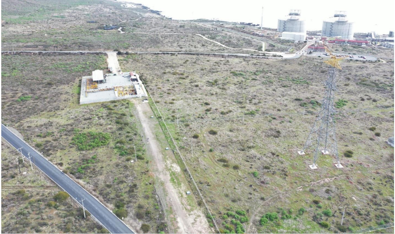
Imagen II.29. Fotografía aérea perpendicular que muestra las condiciones actuales dentro del AP. Áreas forestales con VSa/MRC y áreas no forestales, superficies sin vegetación.
