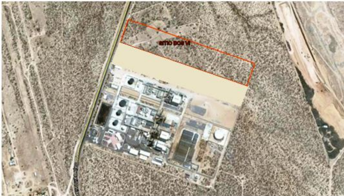
Figura II-1. Predio aledaño a la central CCI Baja California Sur, para instalar la 315 CCI BCS VI.
