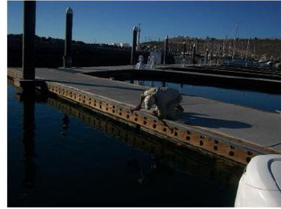
Ajuste de rodillos y flotadores
