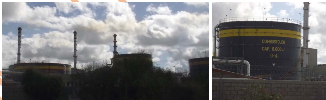
Vista de la Central Termoeléctrica Punta Prieta
