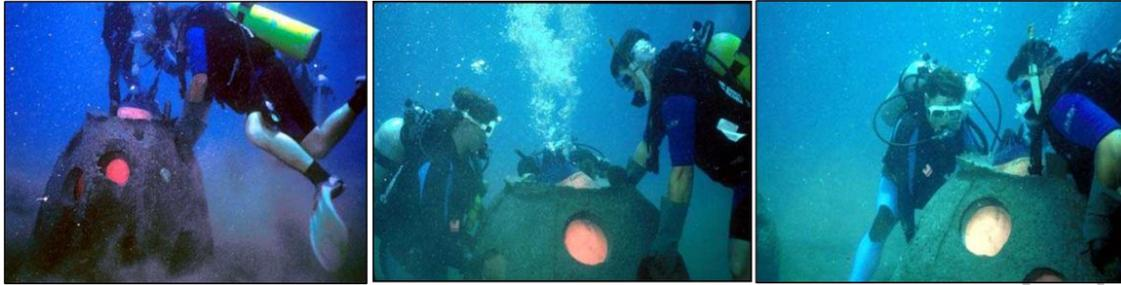
Figura 12. Colocación de estructuras utilizando la técnica de descenso controlado.
