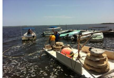
Figura 3. Transporte de las estructuras. A) Terrestre por medio de camiones de carga especializados. B) Marino, utilizando una plancha modificada que es remolcada por una lancha con motor fuera de borda.
