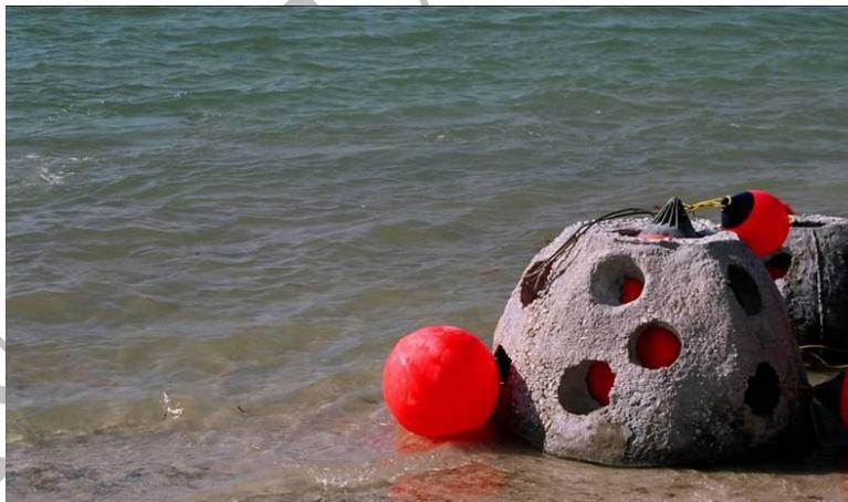
Figura 11. Método de transporte de las estructuras Reef Ball utilizando globos Polyform.
