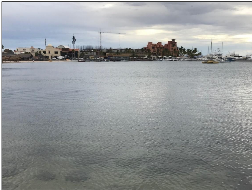
Fotografía No. 6. Vista panorámica donde se instalara el proyecto.
