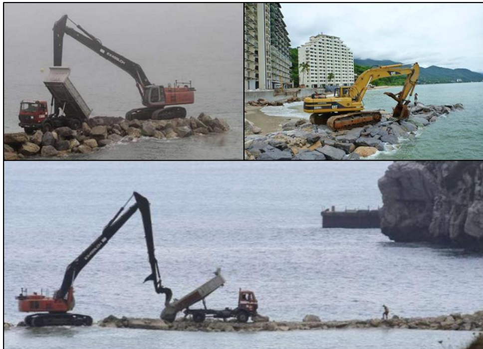
Imagen II.46. Procedimiento constructivo de los enrocamientos (pedaplén y rompeolas).
