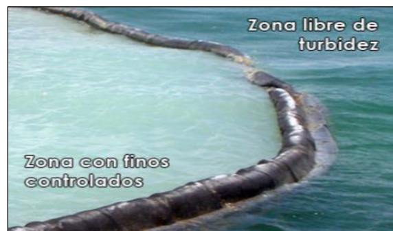
Imagen II.38. Ejemplo de instalación de cortina antidispersión.
