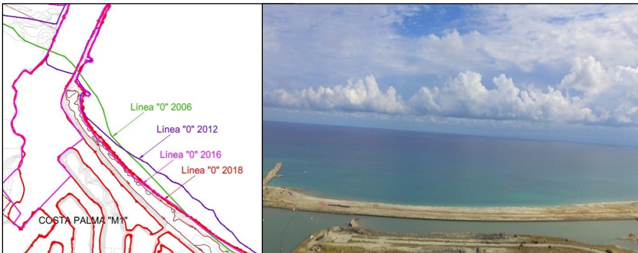
Imagen II.18 Erosión en zona M1. Izquierda) Comparación de la línea de costa. Derecha) Playa erosionada (2019).
