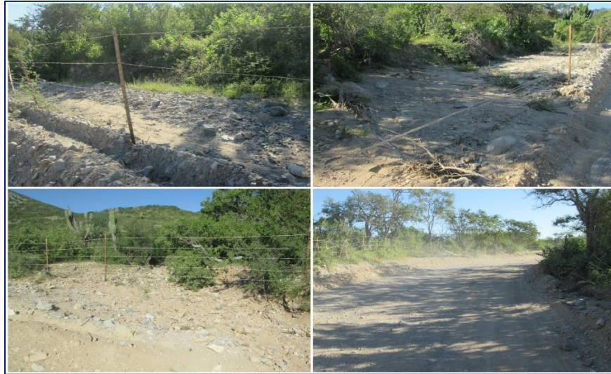
FIGURA 37. Condiciones generales de la escorrentía intermitente “2” situada en el cadenamiento 1+151.55.
