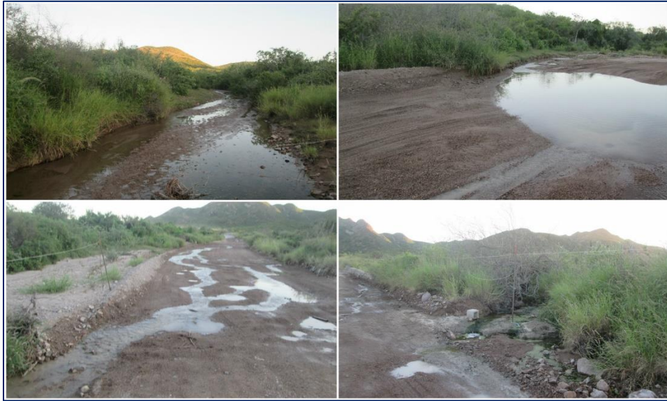
FIGURA 55. Condiciones generales de la escorrentía intermitente "8" situada en el cadenamiento 7+235.52.
