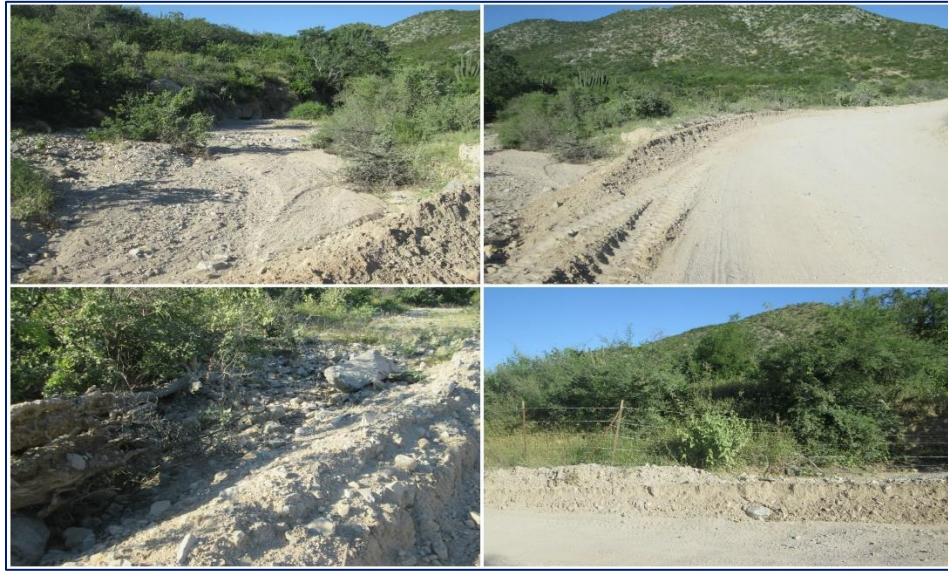
FIGURA 34. Condiciones generales de la escorrentía intermitente "1" situada en el cadenamiento 0+382.34.
