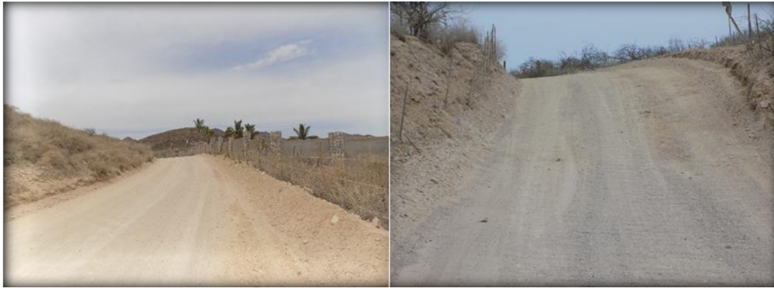
FIGURA 10. Condiciones actuales que presenta el camino El Rincón - Cabo Pulmo.
