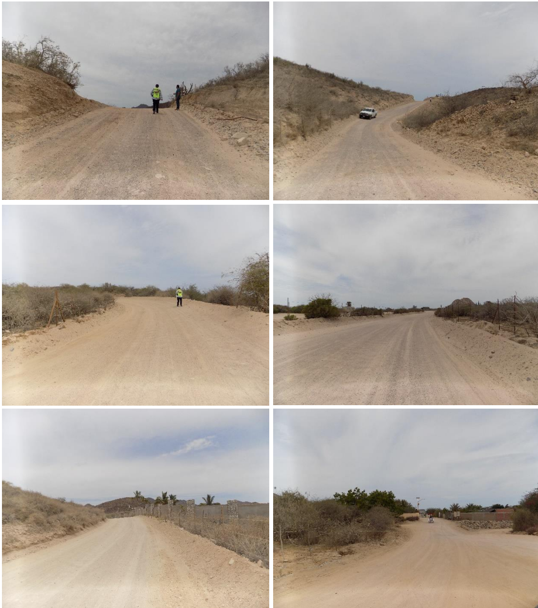
FIGURA 4. Vista general de las condiciones actuales del camino
