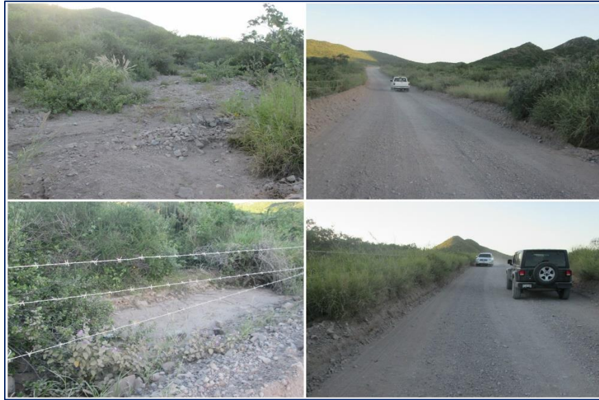
FIGURA 58. Condiciones generales de la escorrentía intermitente “9” situada en el cadenamiento 7+771.00.
