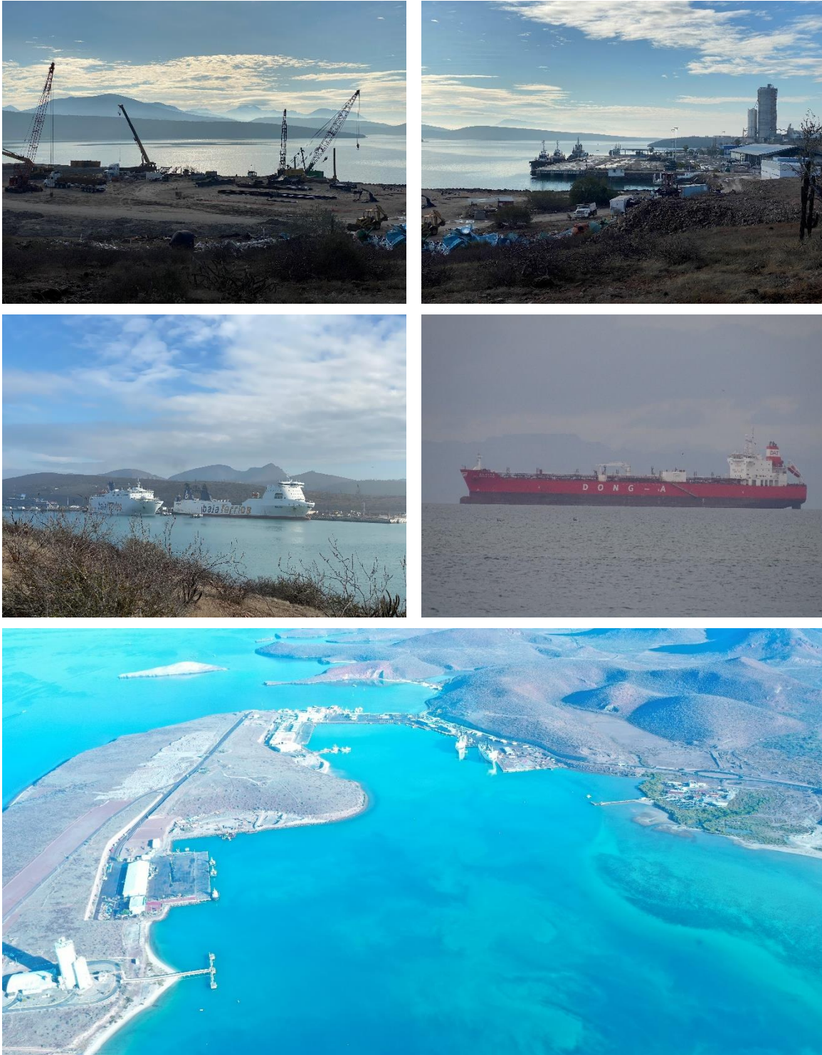
Figura II-3. Áreas establecidas y actividades que se llevan a cabo dentro del puerto de Pichilingue.
