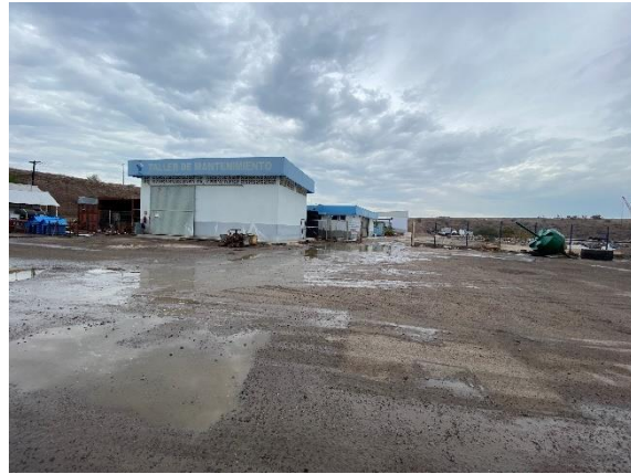
Taller de mantenimiento
