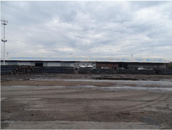
Cobertizo y bodegas (al fondo)
