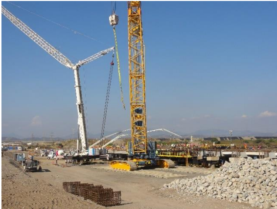
Vista general del proceso constructivo de un muelle
