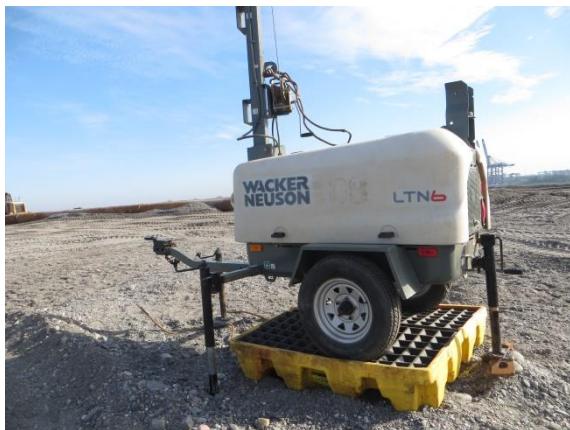
Protección de equipos contra fuga de hidrocarburos
