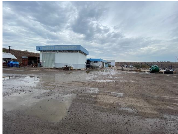
Taller de mantenimiento
