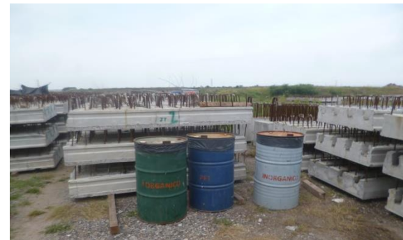
Instalación de contenedores para la colecta temporal de residuos sólidos urbanos.
