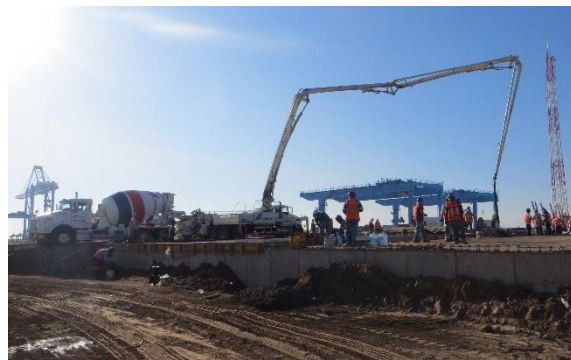
Olla y bomba de concreto
