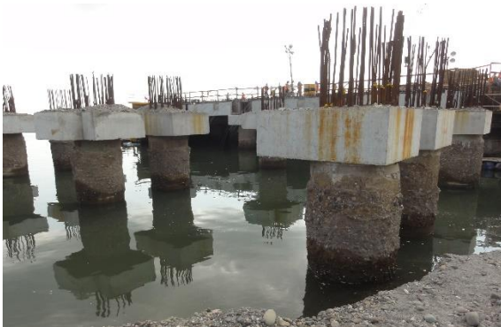
Construcción de pilas con sus capiteles
