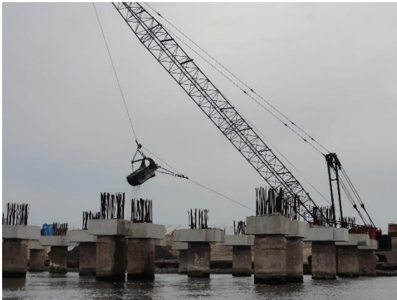
Dragado mecánico con ostra
