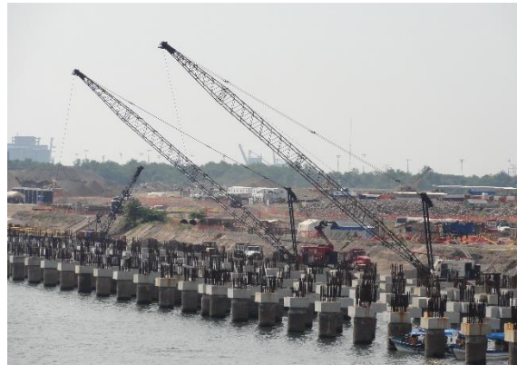
Conformación de red de pilas para la construcción de un muelle
