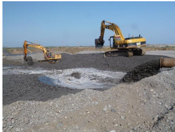
Desfogue y acomodo del material dragado por succión en la tarquina
