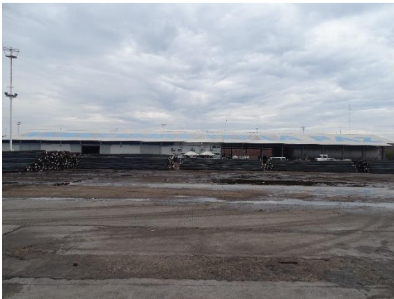
Cobertizo y bodegas (al fondo)
