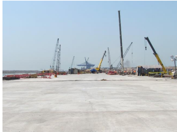
Vista general de una sección colada de la plataforma
