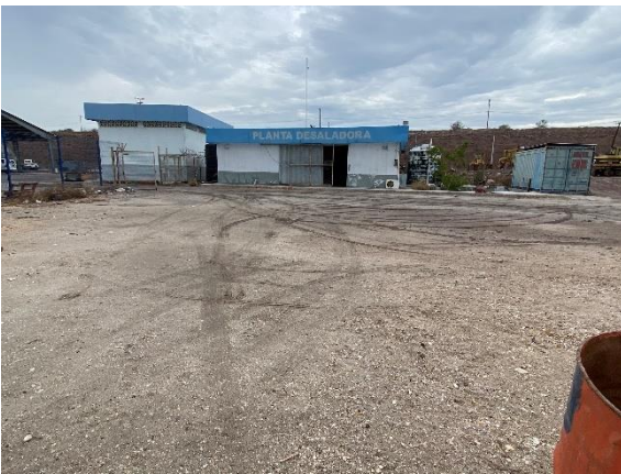
Planta desaladora de ósmosis inversa
