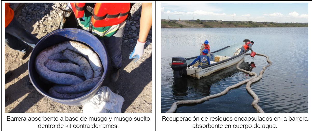
Figura VI—1. Ejemplo de impactos ambientales valorizados como compatibles y su medida ambiental a implementar para prevenirlos o mitigarlos.
