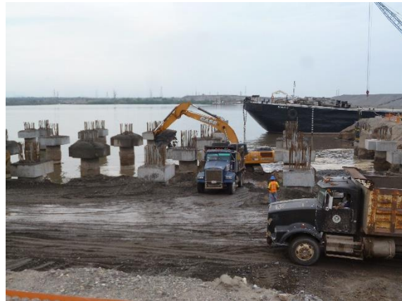
Dragado mecánico con retroexcavadora y transporte del material
