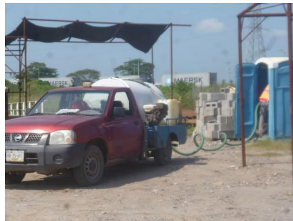
Mantenimiento a baños portátiles en un frente de trabajo por personal de una empresa especializada.
