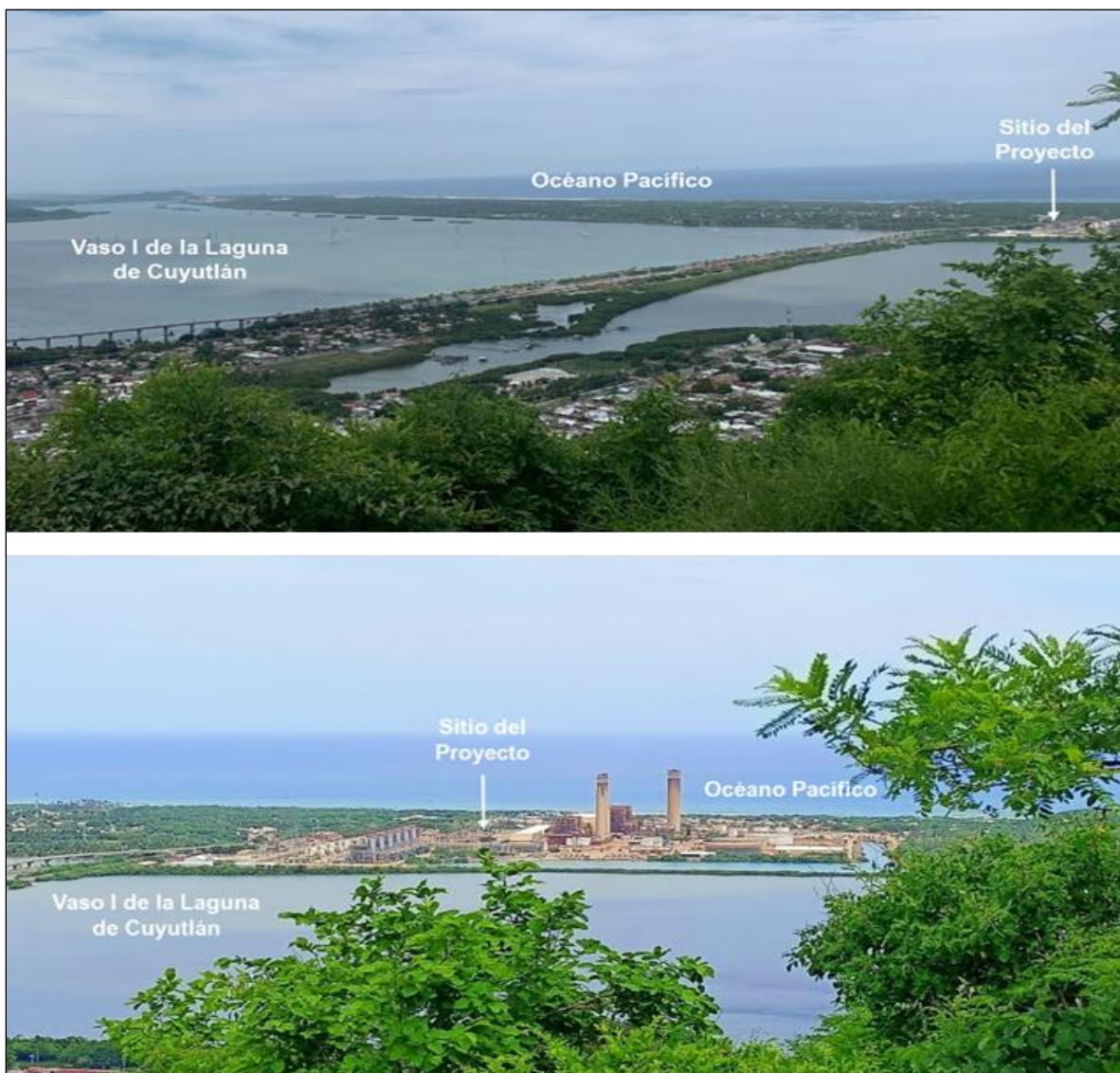
Foto I.1.2-1. Vista panorámica de la ubicación general del predio que se pretende ocupar con el Proyecto
