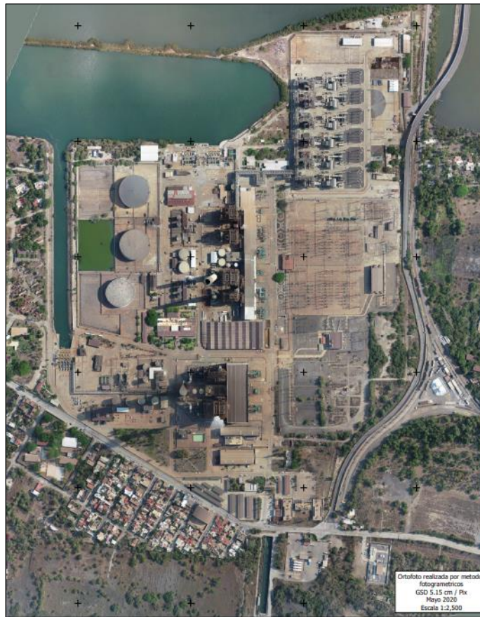
Figura II.1.1-1. Predio e instalaciones de la CCC y CT Gral. Manuel Álvarez Moreno
