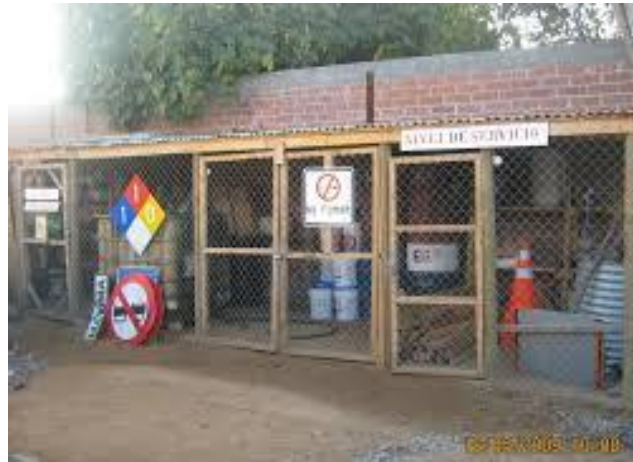
Foto II.3.b. La imagen muestra un ejemplo de un almacén para residuos peligrosos instalado de forma temporal, con firme de concreto, ventilado y con estructuras removibles para facilitar su retiro al culminar la obra.
