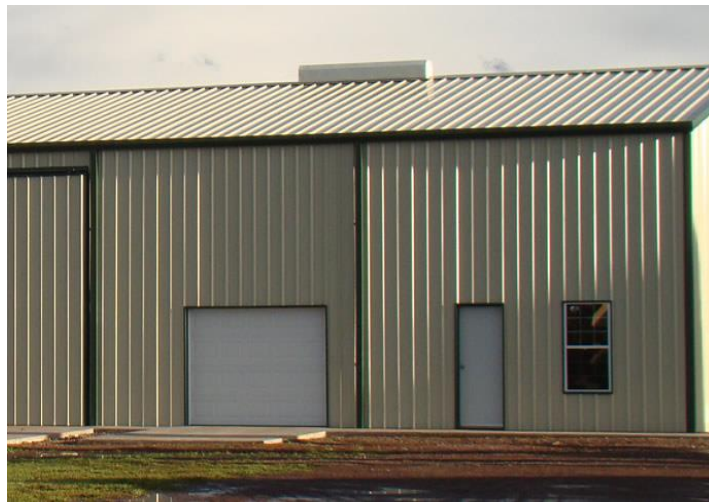
Foto II.3.a. La imagen muestra un ejemplo de una bodega de obra instalada de forma temporal con paneles removibles para facilitar su retiro al culminar la obra.
