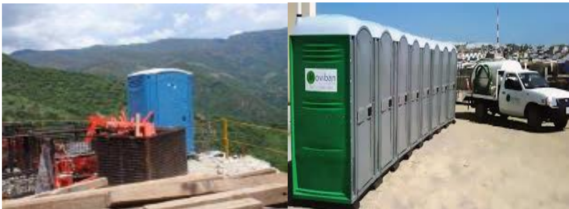
Fotos II.6. Las imágenes muestran ejemplos de los sanitarios portátiles empleados en obra.
