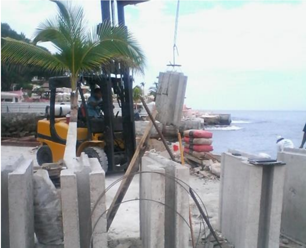
Elaboración y colocación de las pantallas
