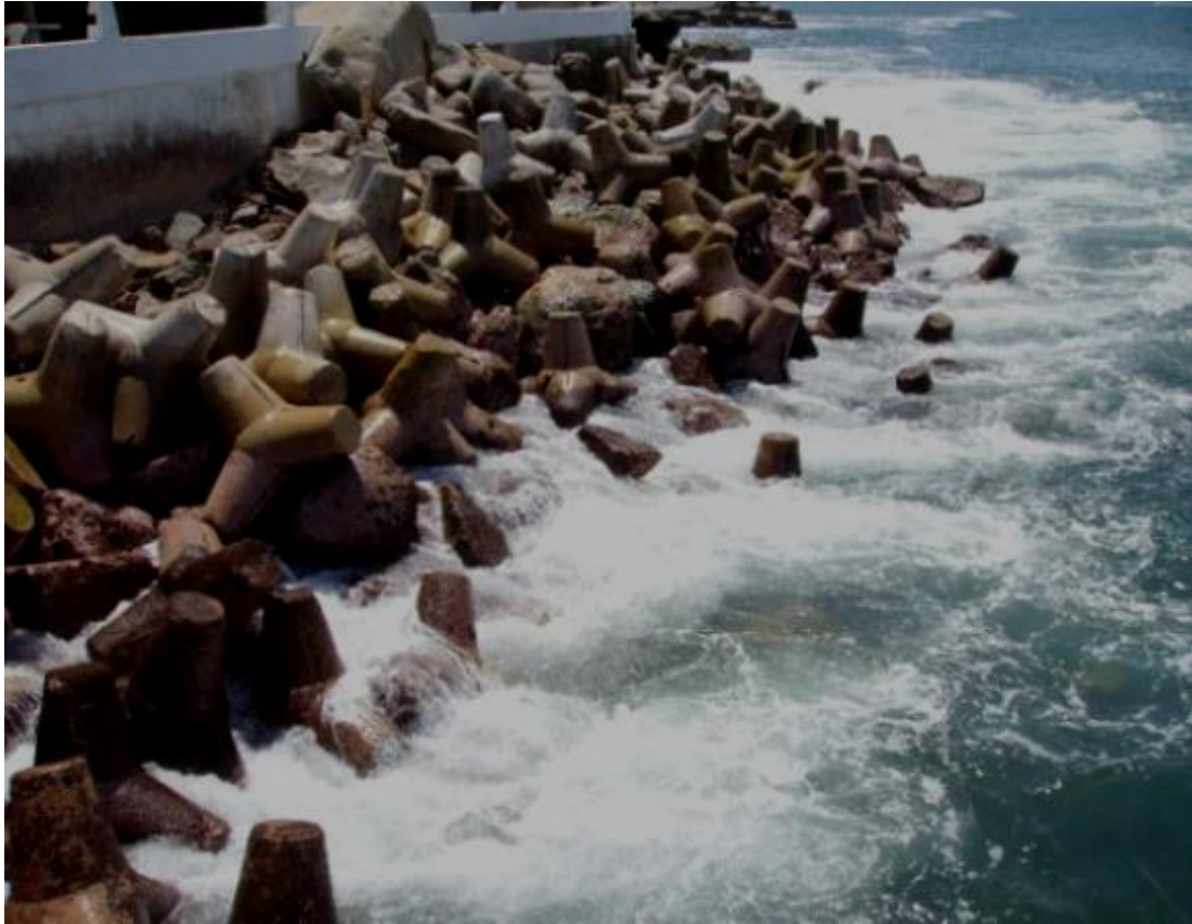
Figura 3. Colocación de los tetrápodos.
