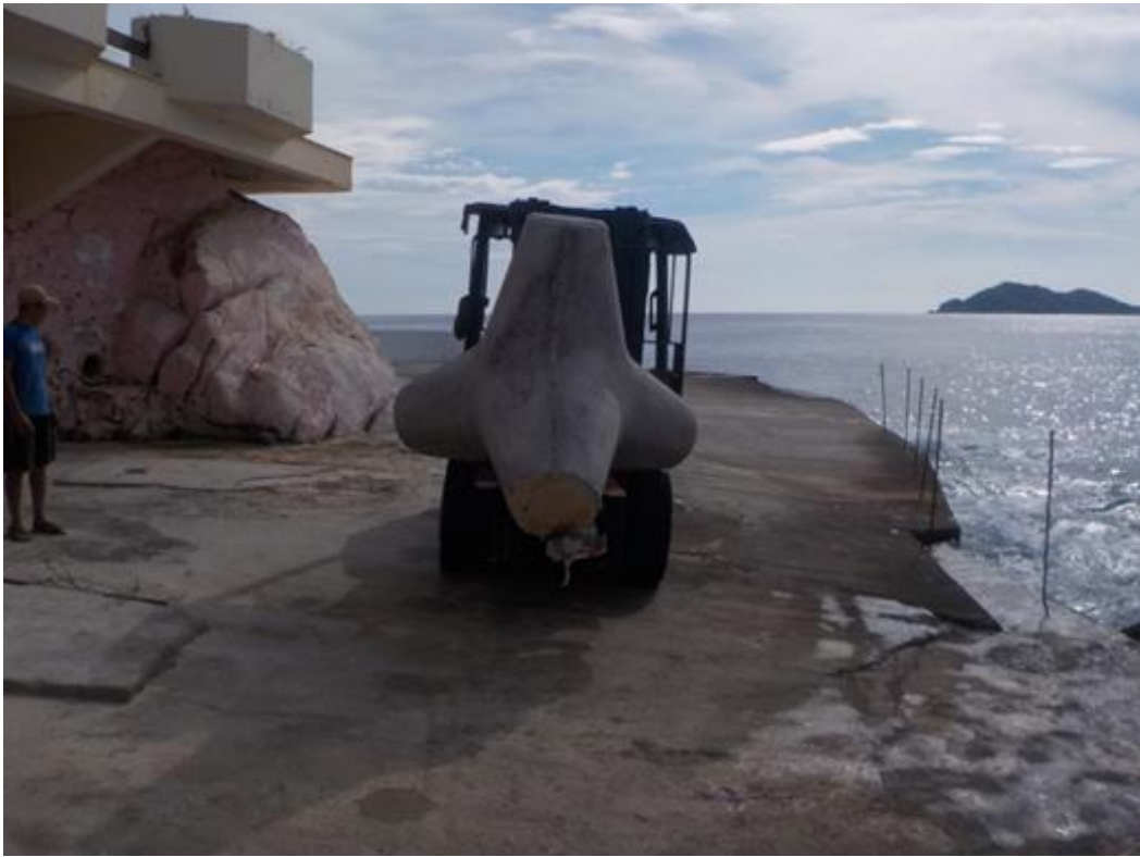
Elaboración y colocación de los Tetrápodos
