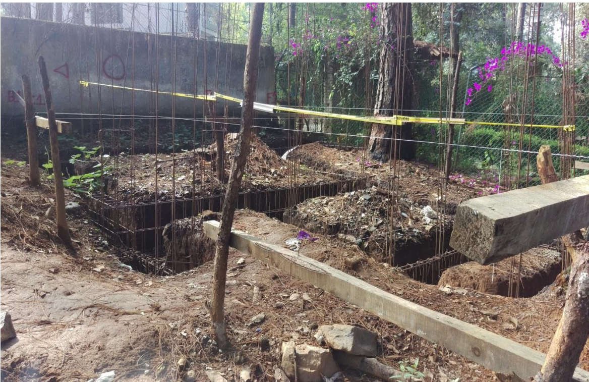
Foto 4.- Armado de traves de varilla y alambre dentro de las cepas para la mampostería.
