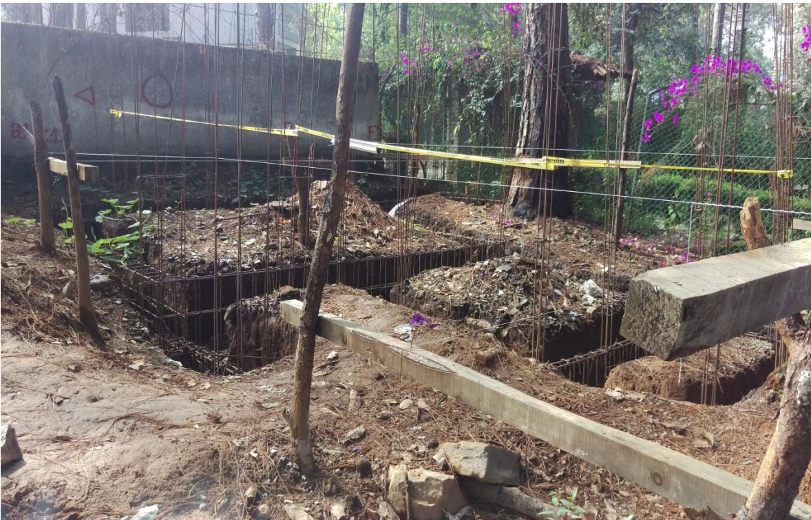
8.- Estructura de varilla y alambre para las traveses de las cimentaciones.
