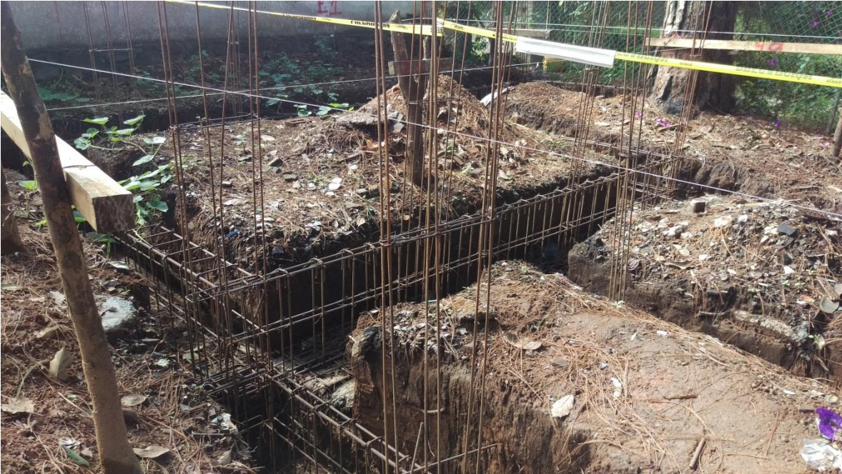
7.-Estructura de varilla y alambre para las traveses de las cimentaciones.
