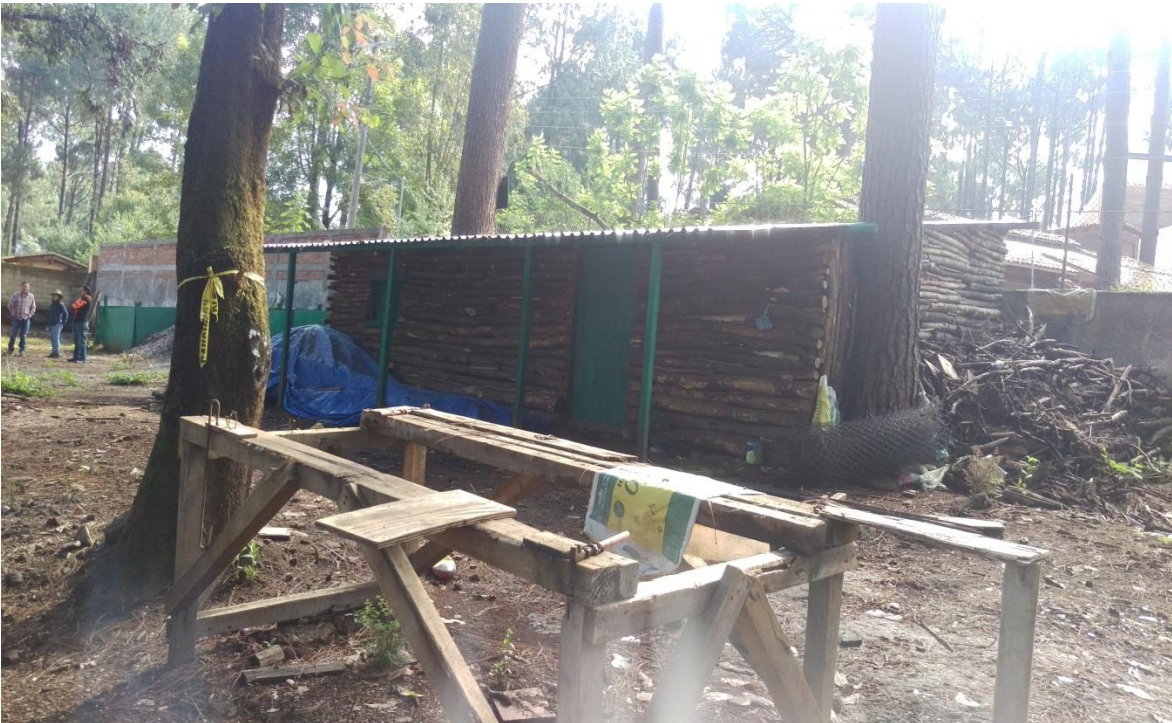
Foto 2.- Cabaña temporal hecha de brazuelo, no tiene pisos ni fijación alguna.
