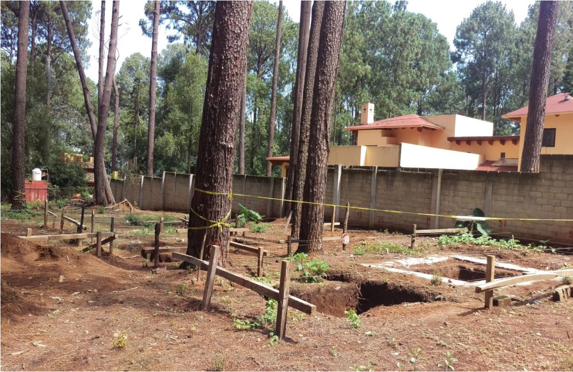
Foto 5.- Excavaciones para las cimentaciones del proyecto. En la imagen se puede observar que el predio colinda con casas habitación.
