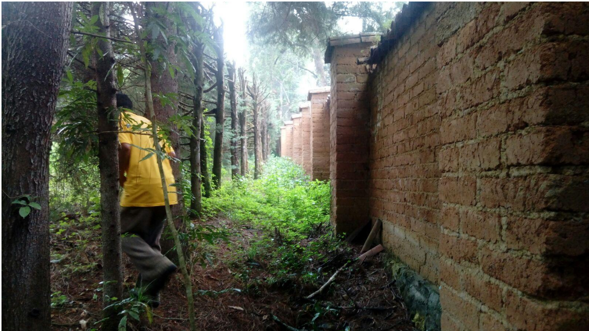
Foto 2.- Parte de la barda perimetral existente.
