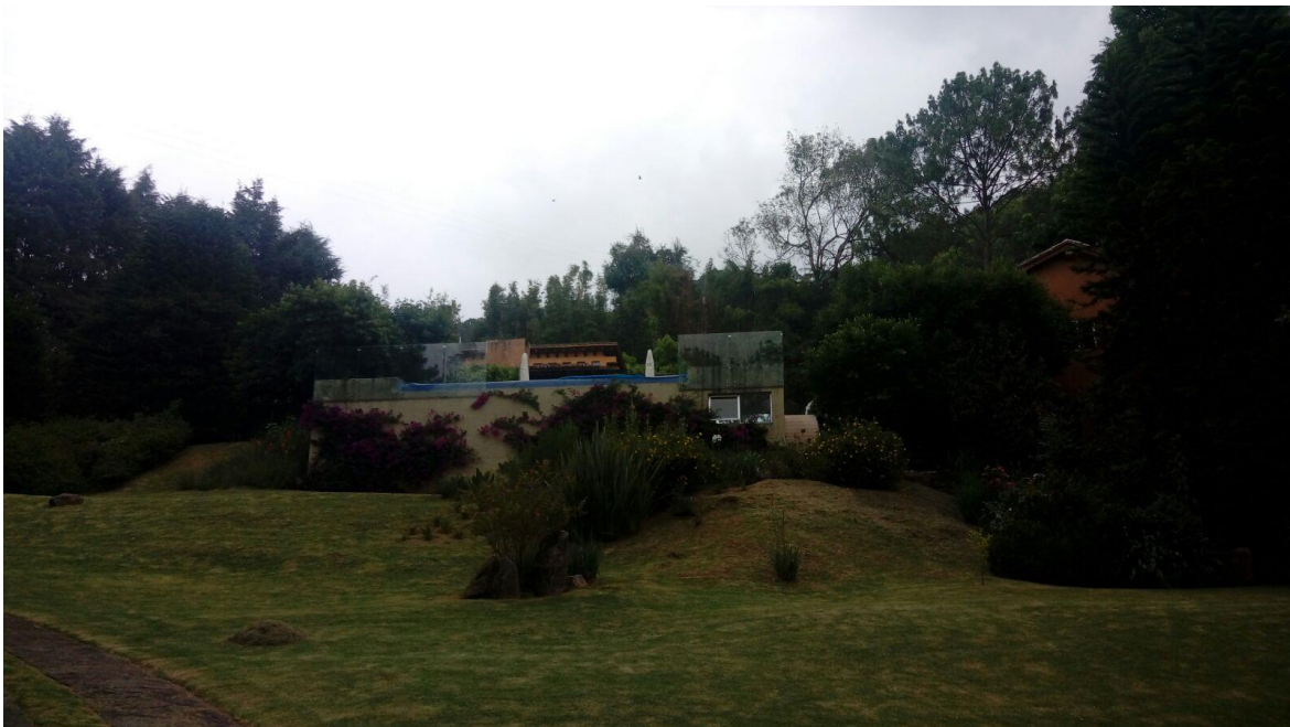
Foto 4.- construcción existente dentro del predio.
