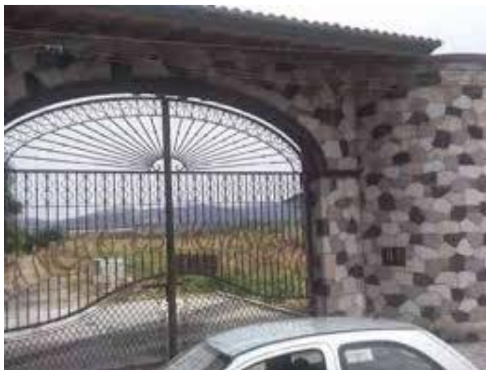
Figura 7. DETALLE DE LA PROYECCIÓN DE LA CASETA DE CONTROL DE ACCESO Y VIGILANCIA
