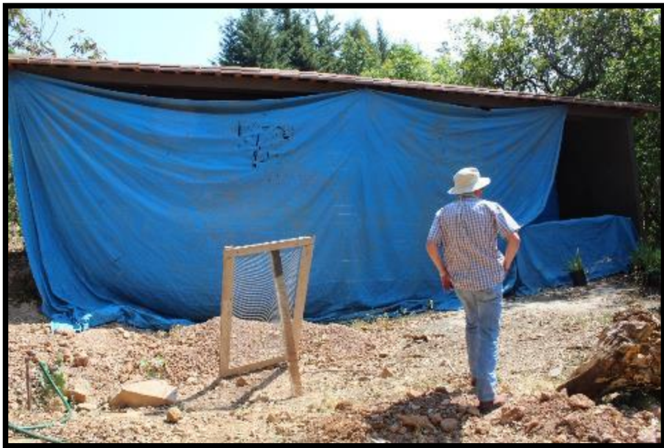
Área de tinacos (condición actual).
