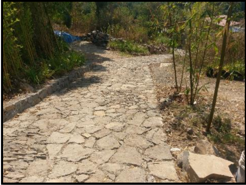
Andador interno (condición actual).
