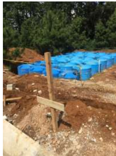
ZONA DE BIODIGESTORES Y CISTERNAS AUTORIZADOS POR EL ORGANISMO MUNICIPAL DE AGUA POTABLE (Y ZONA ARBOLADA AL FONDO QUE NO SE TOCÓ)
