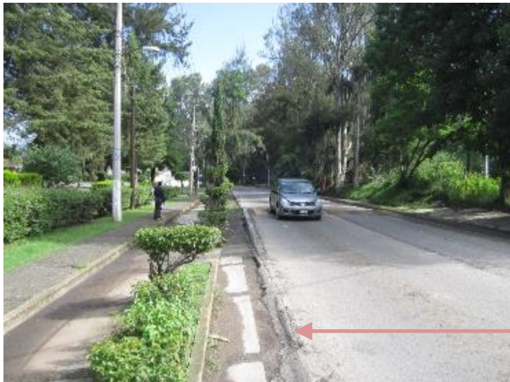
Km 36+450 (toma norte a sur)
