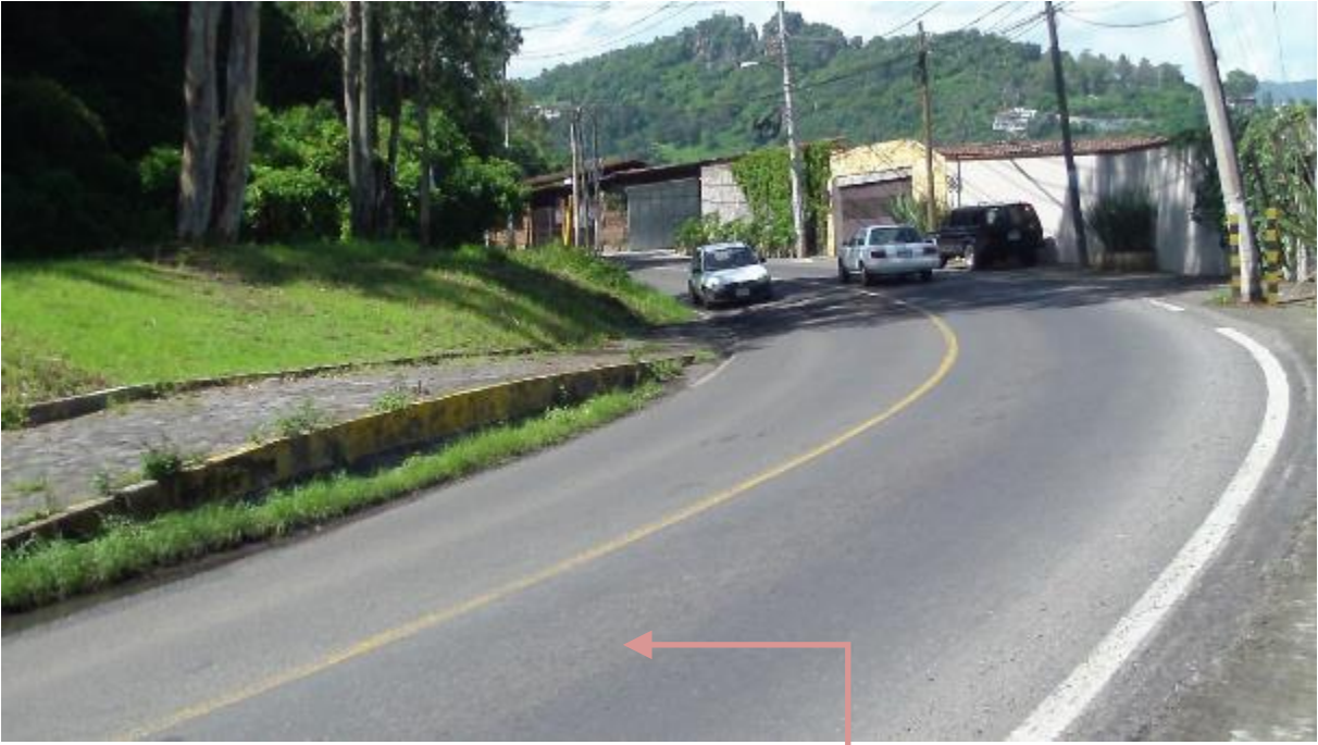
Vía: carretera Toluca-Valle de Bravo (toma sureste a noroeste)
