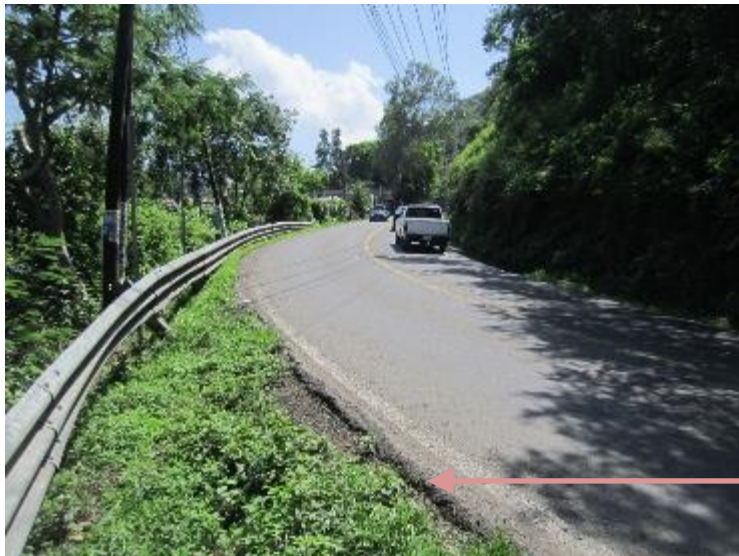
Km 34+200 (toma norte a sur)
