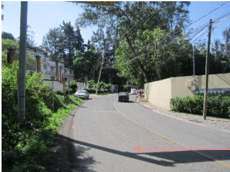
Km 35+520 (toma norte a sur)
