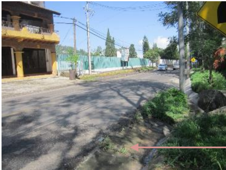
Km 35+850 (toma norte a sur)
