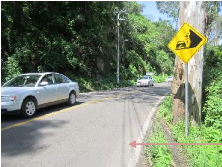
Km 34+850 (toma norte a sur)
