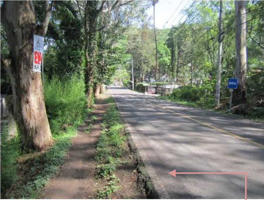
Vía: carretera Toluca-Valle de Bravo (toma sureste a noroeste)
