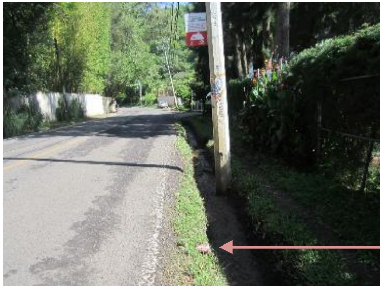
Km 35+550 (toma norte a sur)
