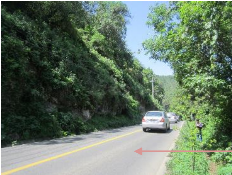
Km 33+900 (toma norte a sur)
