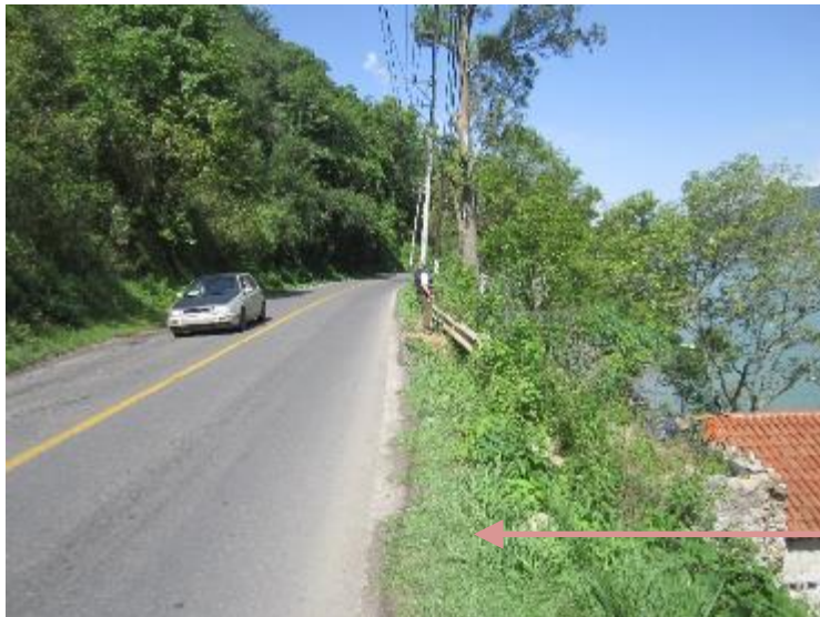
Km 34+930 (toma norte a sur)
