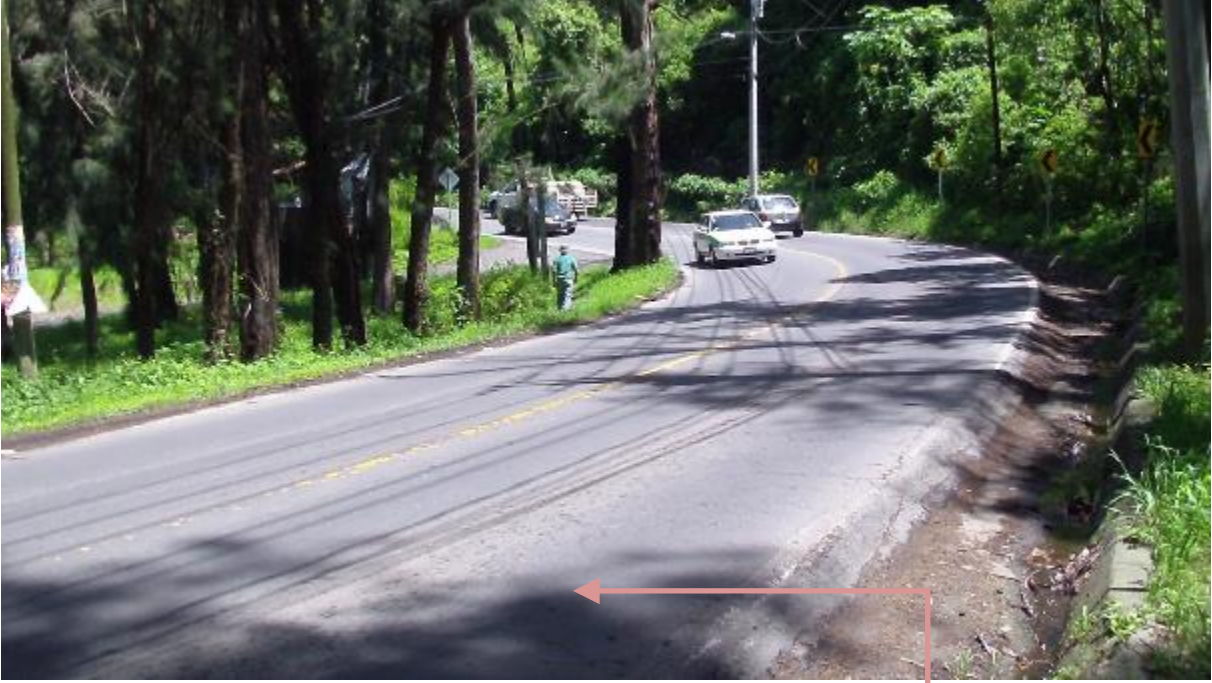
Vía: carretera Toluca-Valle de Bravo (toma noreste a suroeste)
