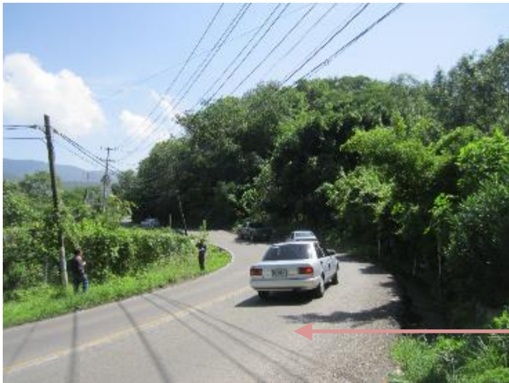
Km 34+600 (toma norte a sur)
