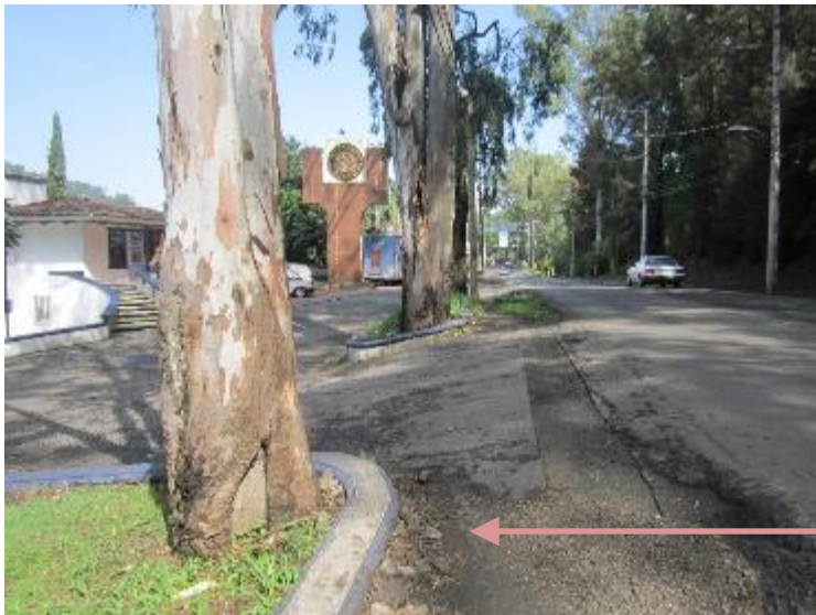
Km 36+000 (toma norte a sur)
