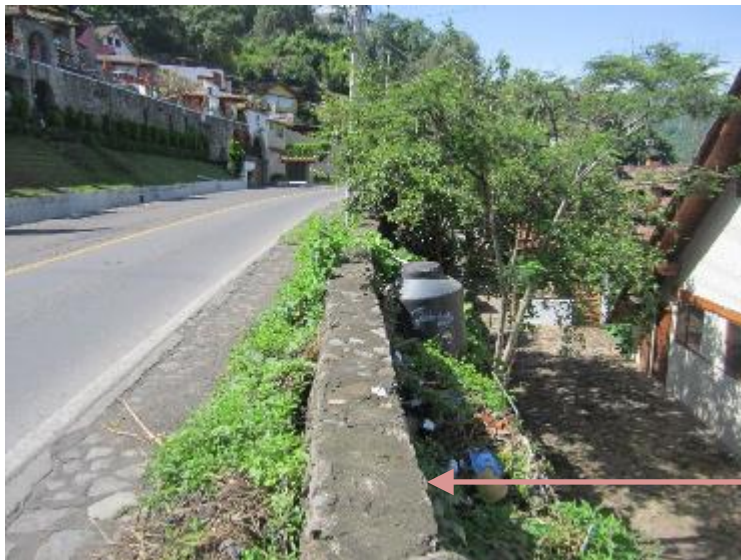
Km 35+220 (toma norte a sur)
