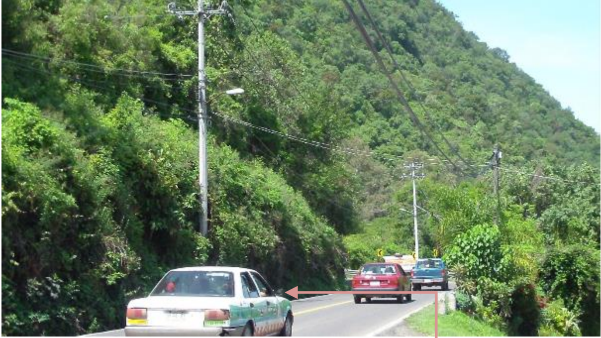
Vía: carretera Toluca-Valle de Bravo (toma sureste a noroeste)
