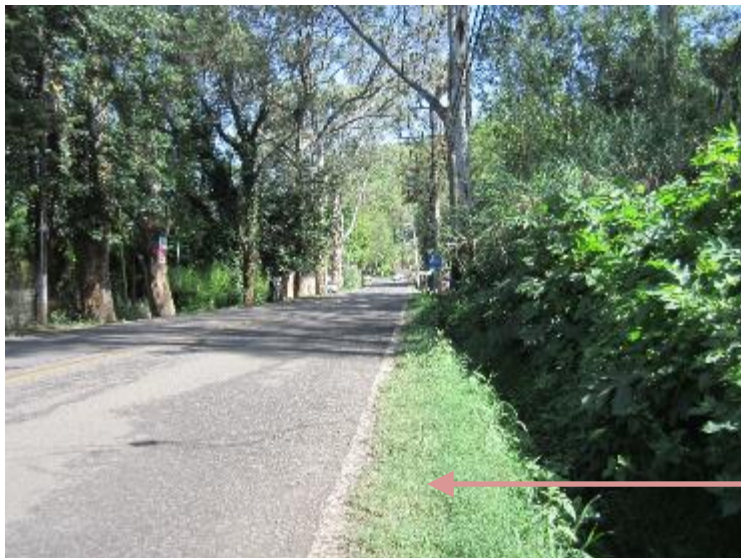
Km 35+580 (toma norte a sur)
