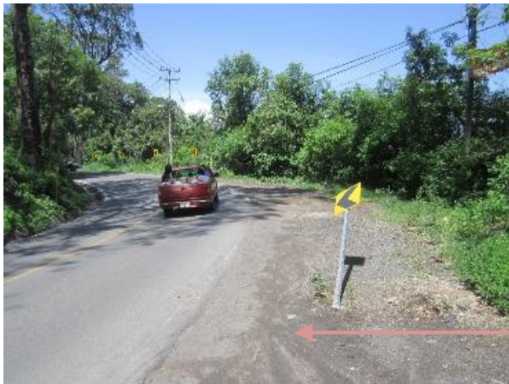
Km 33+300 (toma norte a sur)
