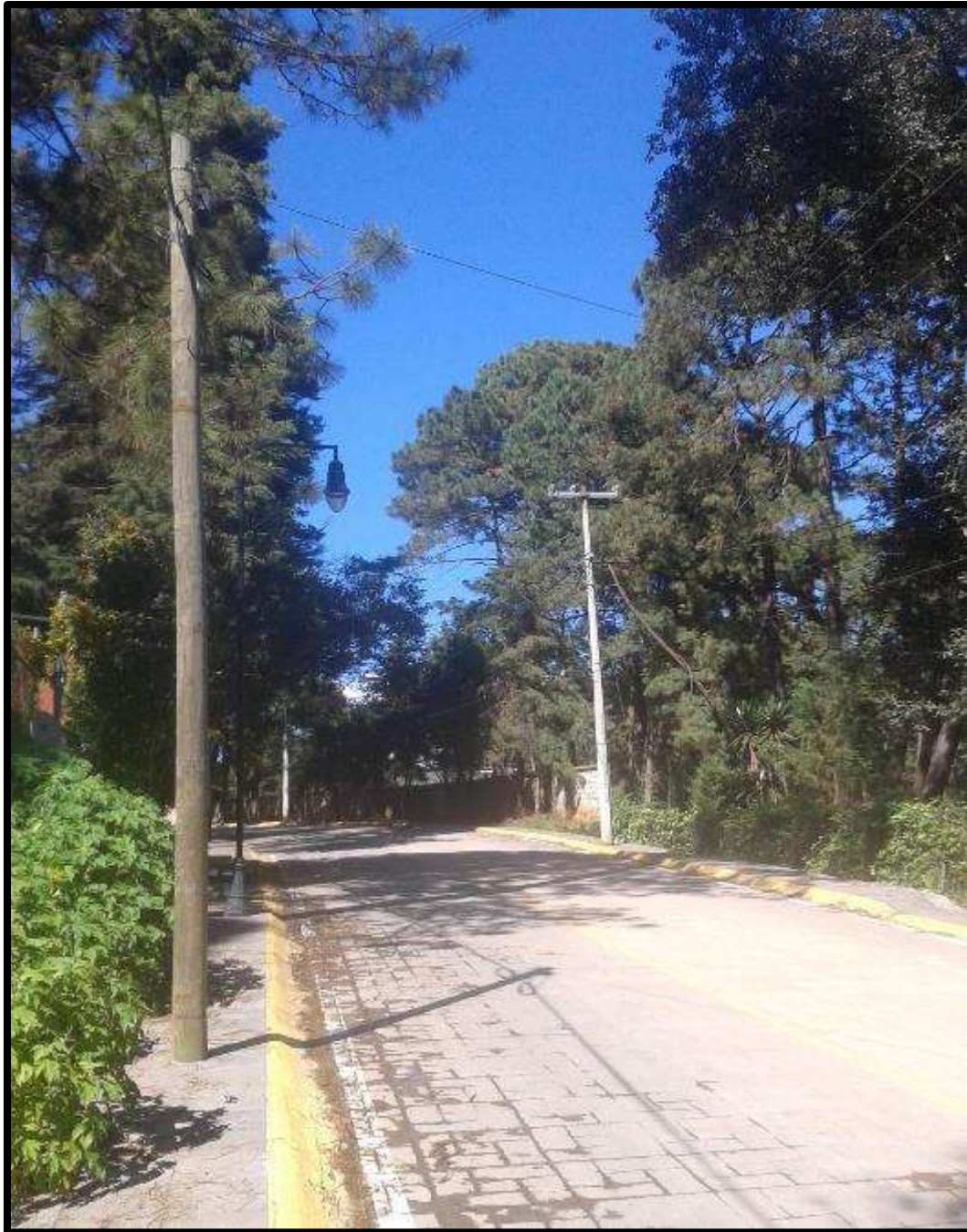
Ilustración 2. Servicio de energía.
