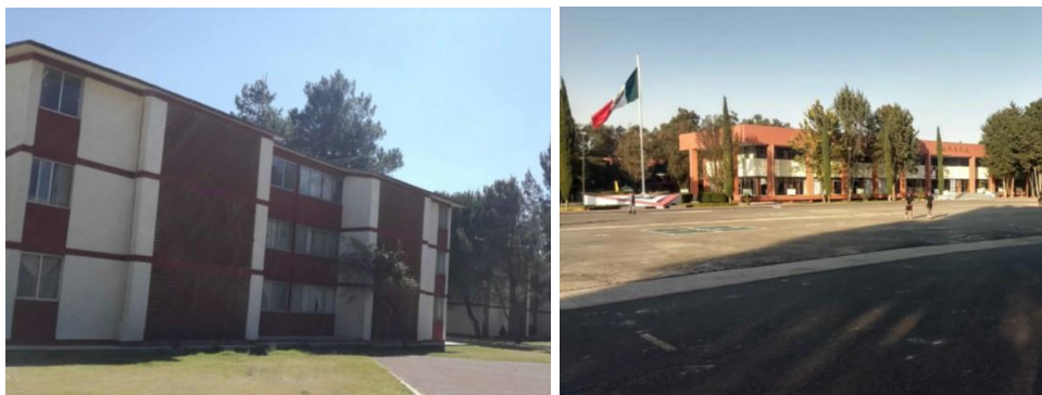
Figura IV.73. Vista general de la infraestructura y construcciones actuales
