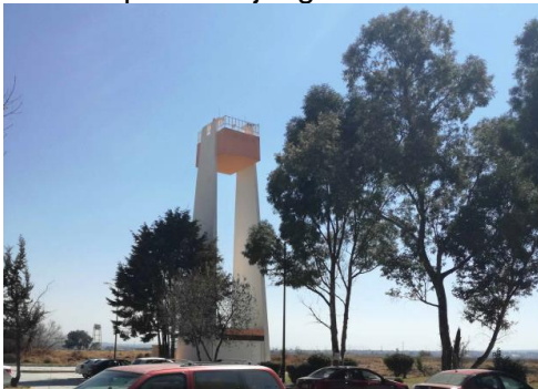
Tanque de agua elevado
