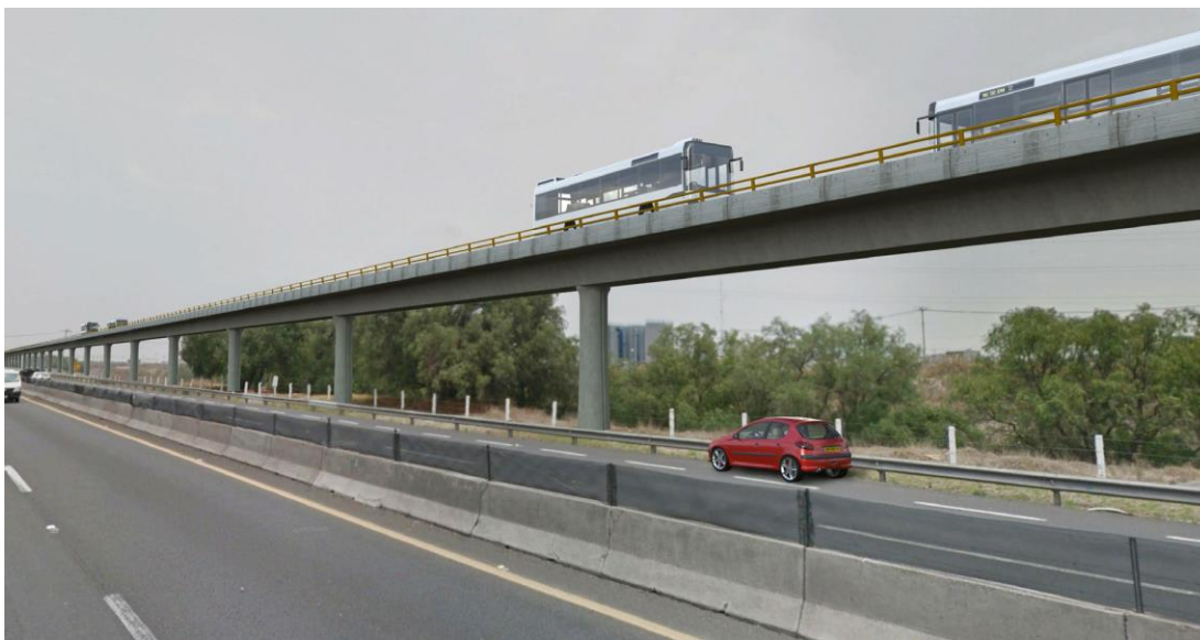
Figura IV.133. Foto de modelo en 3 dimensiones de una vía elevada de carriles confinados para autobús. Imagen demostrativa
