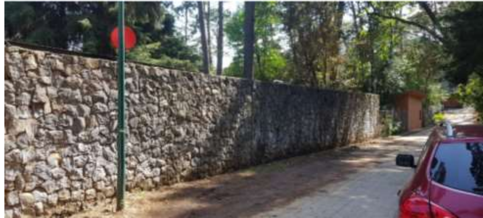
Figura IV. 37. Barda perimetral del predio
