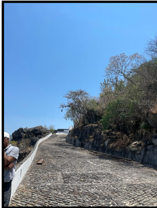
Foto 1. Calles de acceso al predio.
