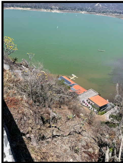
Foto 4. Casas ya existentes.
