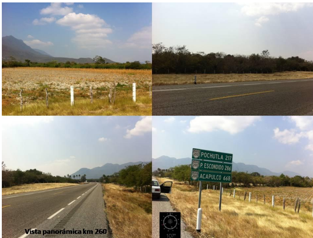
Figura IV.12. Vista panorámica de la zona por donde se pretende instalar el ducto de gas Natural, se señala el grado de deterioro debido a actividades agrícolas, ganaderas y urbanas en la parte del estado de Oaxaca.
