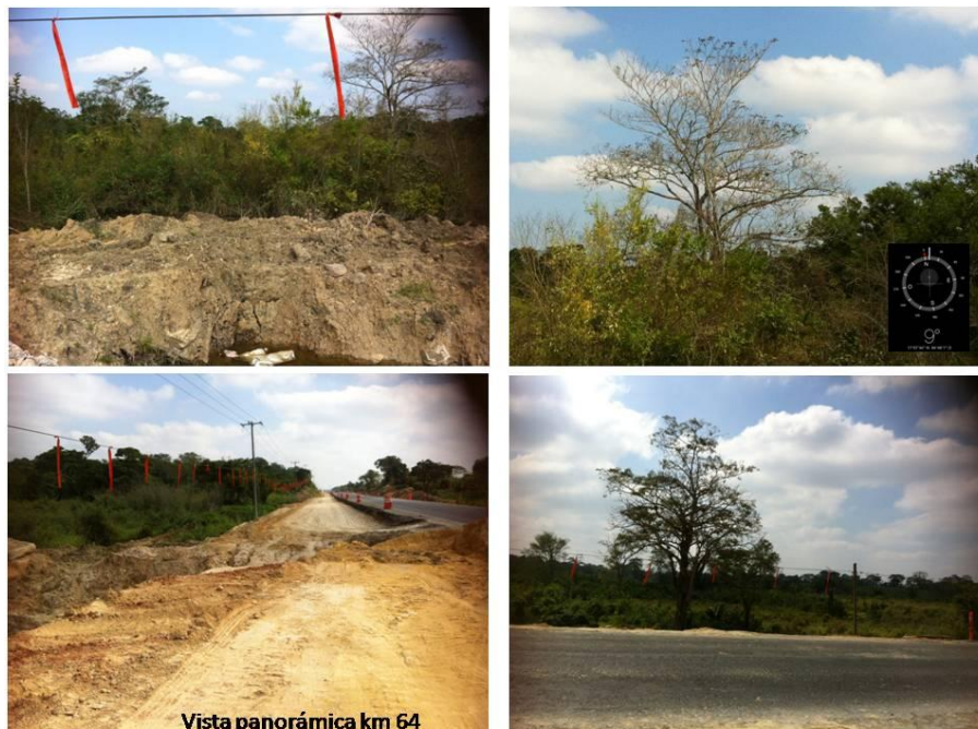
Figura IV. 10. Vista panorámica de la zona en donde se pretende instalar el ducto de gas Natural, se señala el grado de deterioro debido a actividades urbanas en una ampliación de la carretera transitsmica.
