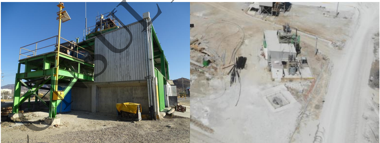
Figura 2.51. Vista general del Relleno hidráulico y vista aérea tomada con Dron en marzo de 2019
