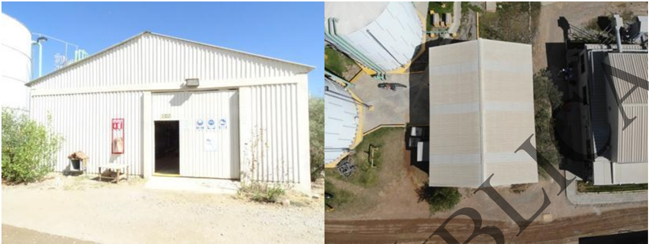
Figura 2.14. Vista general del área de pulimiento y vista aérea tomada con Dron en marzo de 2019
