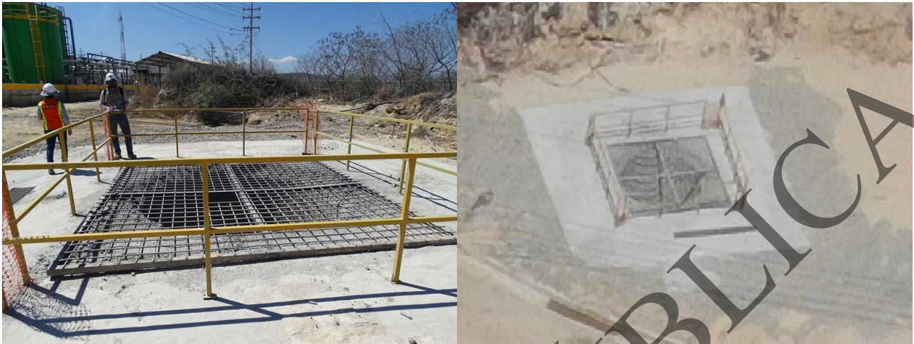
Figura 2.49. Vista general de las Obras asociadas al contrapozo 1 (Rb24) y vista aérea tomada con Dron en marzo de 2019
