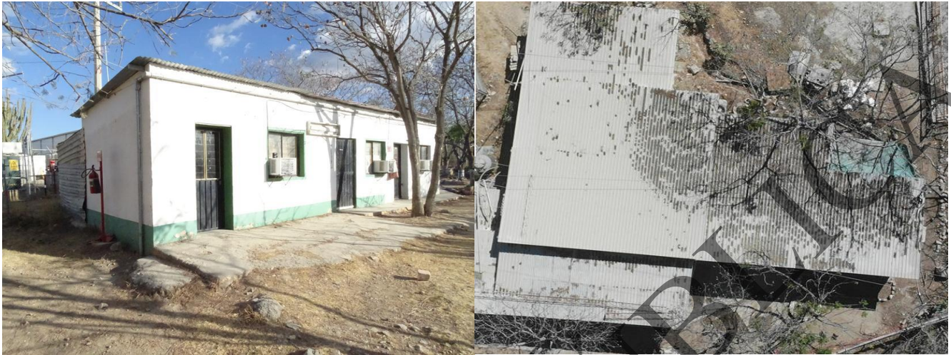
Figura 2.33. Vista general de la brigada de rescate y vista aérea tomada con Dron en marzo de 2019
