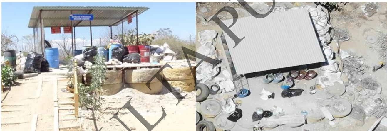
Figura 2.44. Vista general del Almacén de Residuos Sólidos Urbanos y vista aérea tomada con Dron en marzo de 2019
