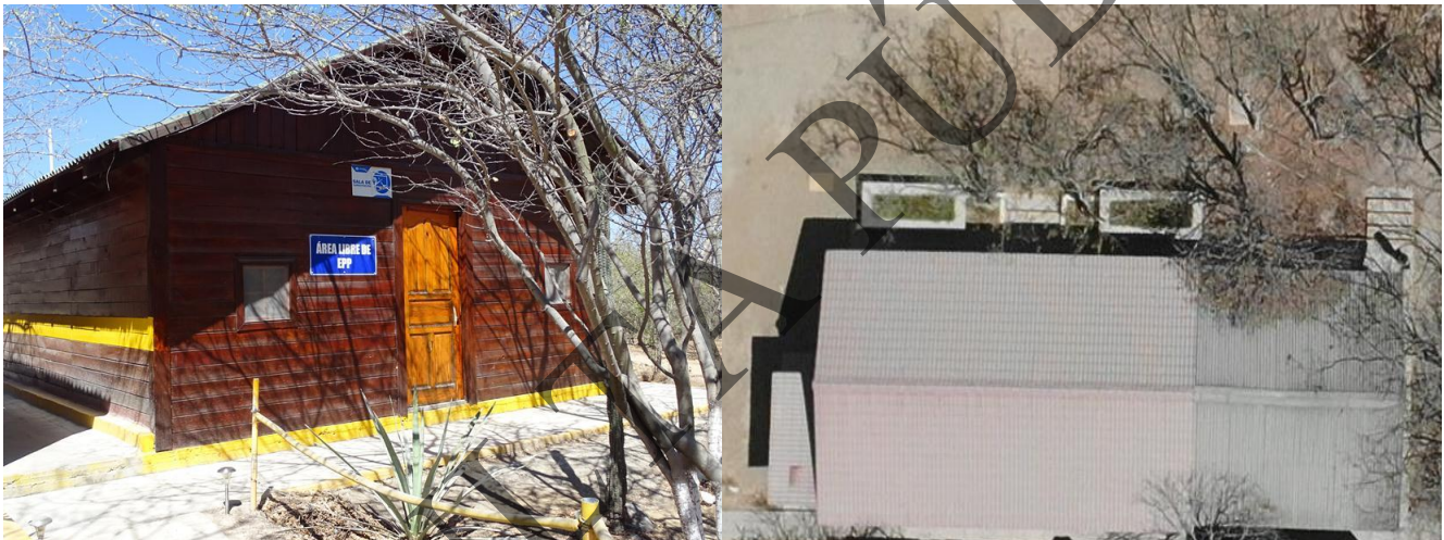
Figura 2.37. Vista general de la Casa de madera y vista aérea tomada con Dron en marzo de 2019
