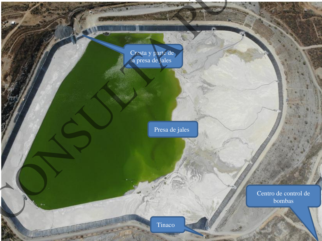
Figura 2.68. Vista aérea tomada con Dron en marzo de 2019, se muestran algunas de los componentes mencionados que conforman la Obra denominada Presa de Jales.
