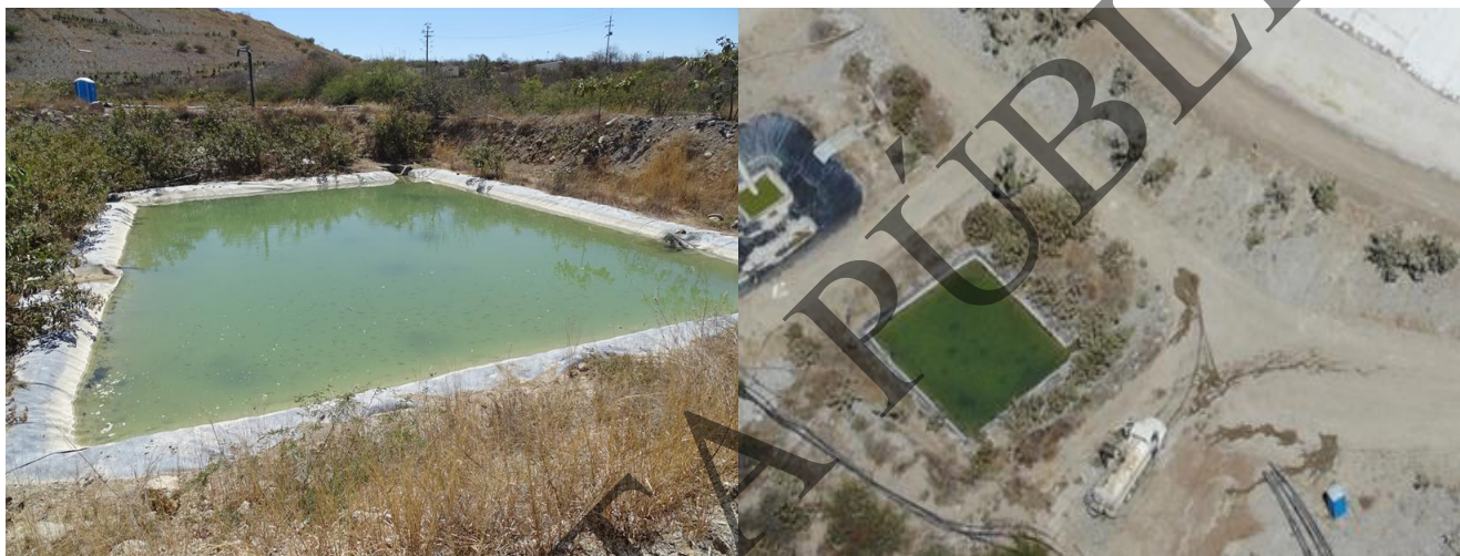
Figura 2.61. Vista general de la Pileta de captación de escurrimientos y vista aérea tomada con Dron en marzo de 2019
