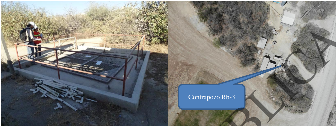
Figura 2.50. Vista general de las Obras asociadas al contrapozo (Rb-3) y vista aérea tomada con Dron en marzo de 2019
