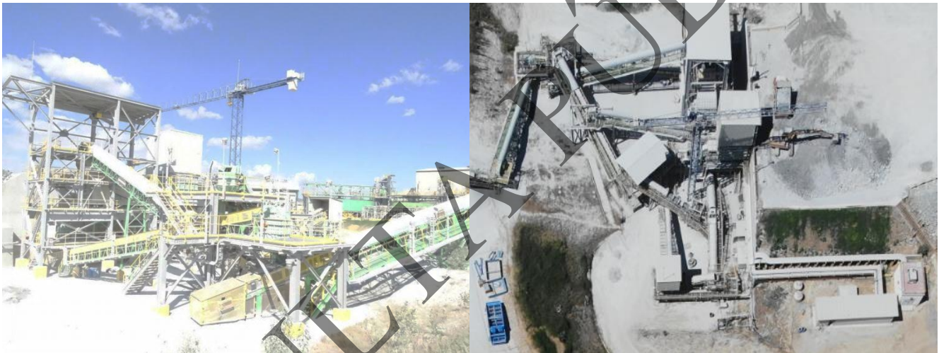
Figura 2.64. Vista general del área de trituración y vista aérea tomada con Dron en marzo de 2019
