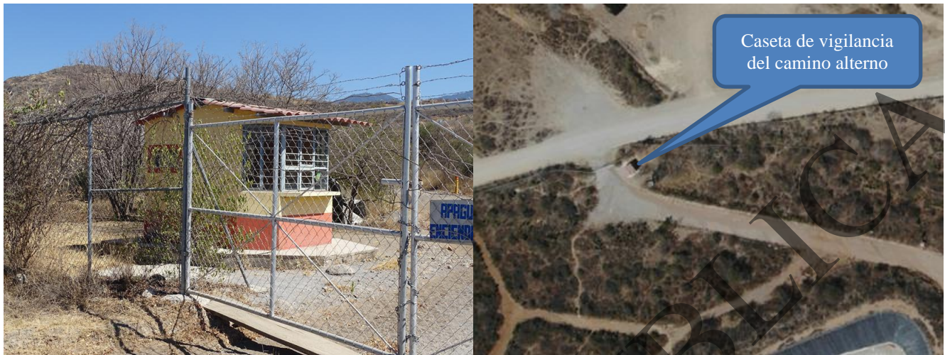
Figura 2.55. Vista general de la Caseta de vigilancia del camino alternativo al polígono Sur y vista aérea tomada con Dron en marzo de 2019
