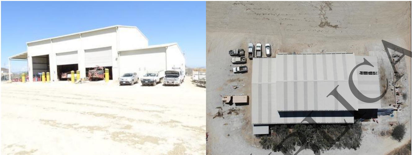
Figura 2.24. Vista general del taller GREMI y vista aérea tomada con Dron en marzo de 2019
