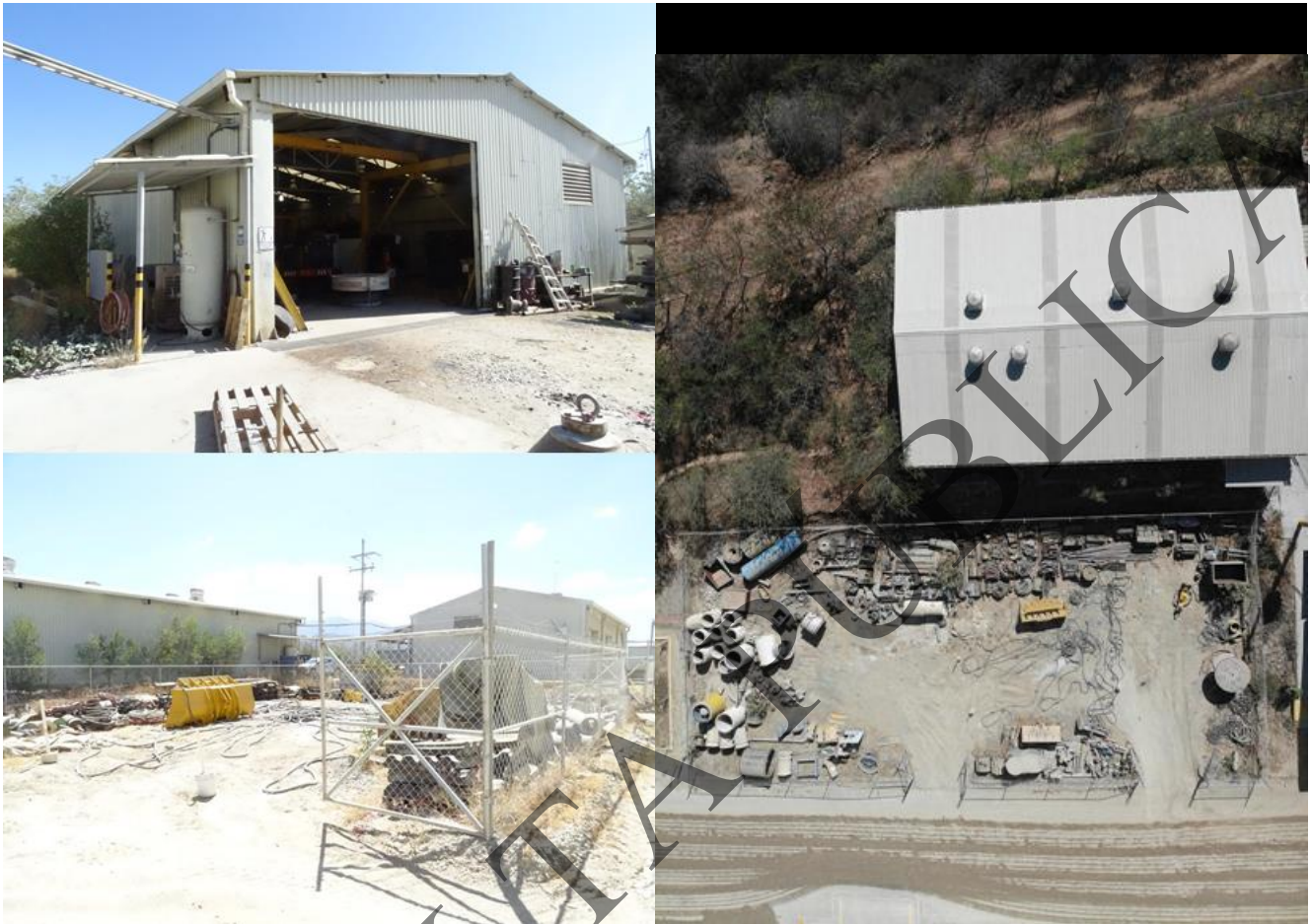
Figura 2.63. Vista general de la Plancha de concreto y sus componentes y vista aérea tomada con Dron en marzo de 2019
