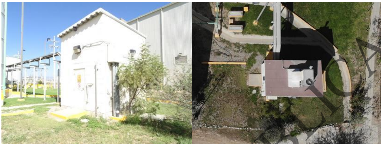
Figura 2.15. Vista general del centro de control de motores y vista aérea tomada con Dron en marzo de 2019
