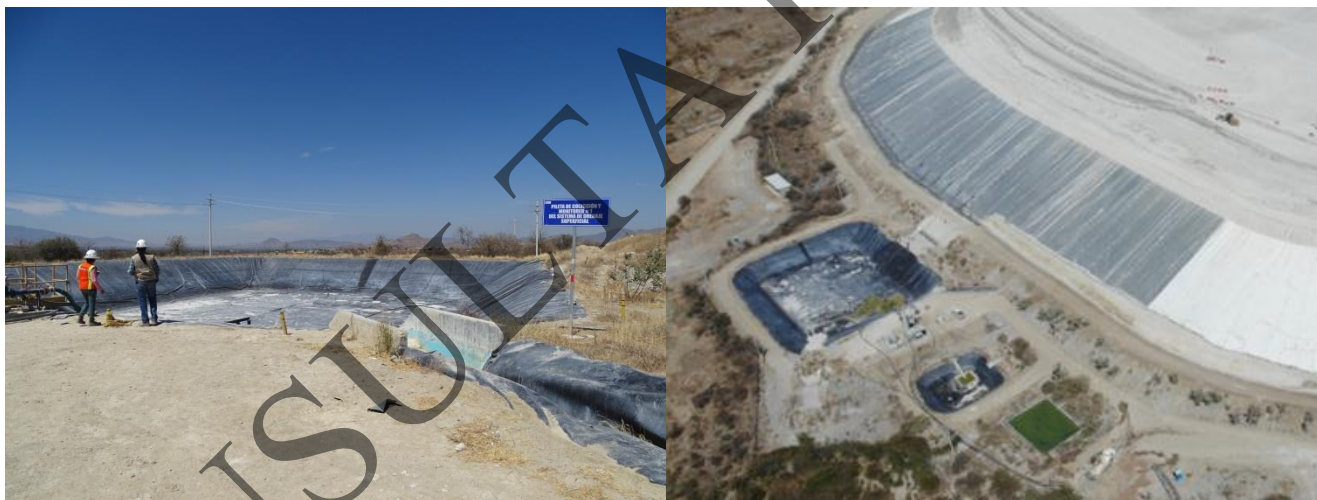
Figura 2.59. Vista general de la Pileta de captación de agua pluvial y vista aérea tomada con Dron en marzo de 2019
