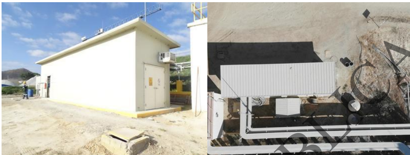
Figura 2.18. Vista general del Cuarto de control de trituración y vista aérea tomada con Dron en marzo de 2019
