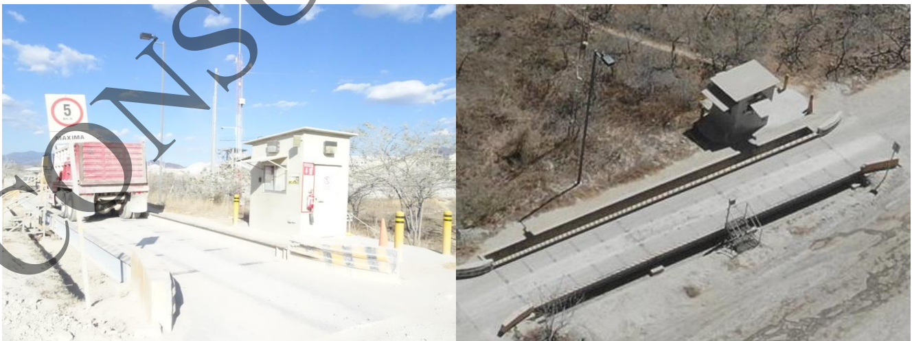
Figura 2.31. Vista general de la caseta del área de báscula y vista aérea tomada con Dron en marzo de 2019
