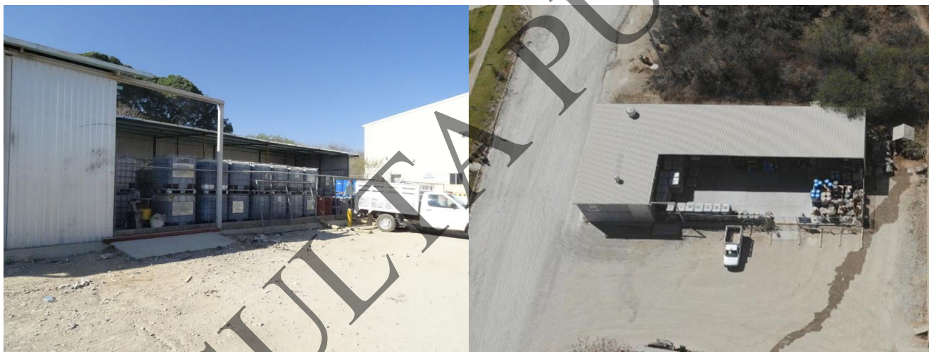
Figura 2.70. Vista general de Almacén de reactivos y área donde se localiza la fosa de captación de agua pluvial y vista aérea tomada con Dron en marzo de 2019
