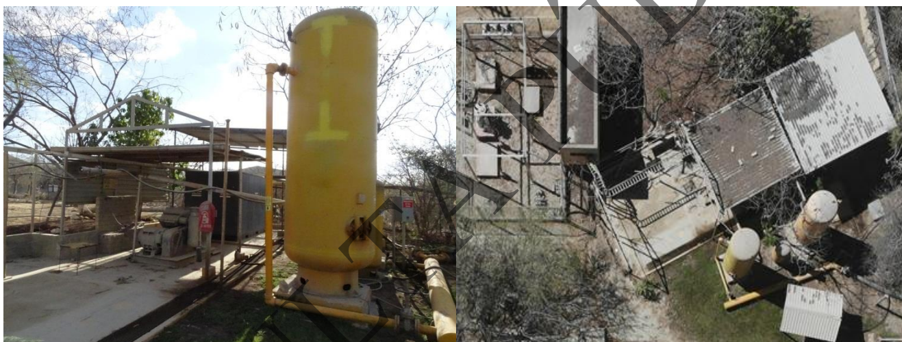
Figura 2.32. Vista general del área de compresores y vista aérea tomada con Dron en marzo de 2019
