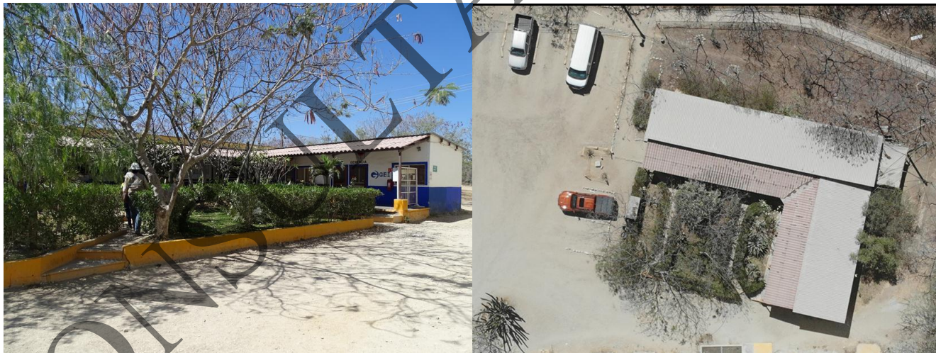
Figura 2.36. Vista general de las oficinas GREMI y vista aérea tomada con Dron en marzo de 2019
