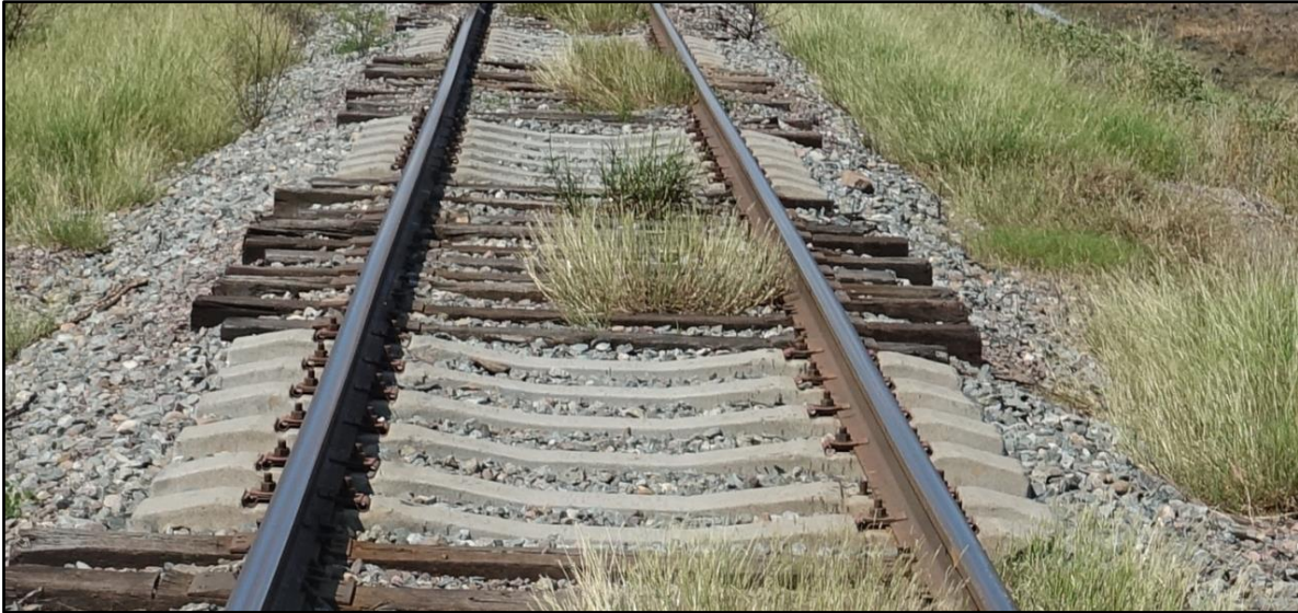
Figura No.16 Diferentes tipos de durmientes, de madera y concreto.
