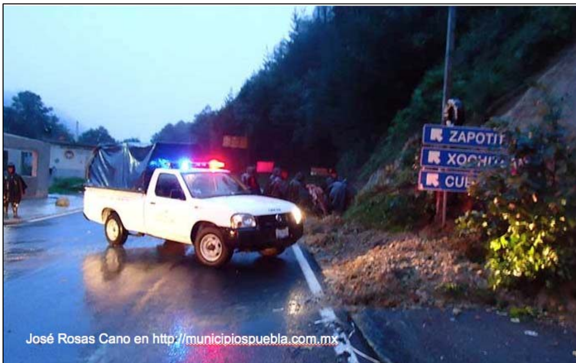
Figura IV.2.1.6-4. Deslaves en la carretera Zacapoaxtla-Cuetzalan, Puebla
