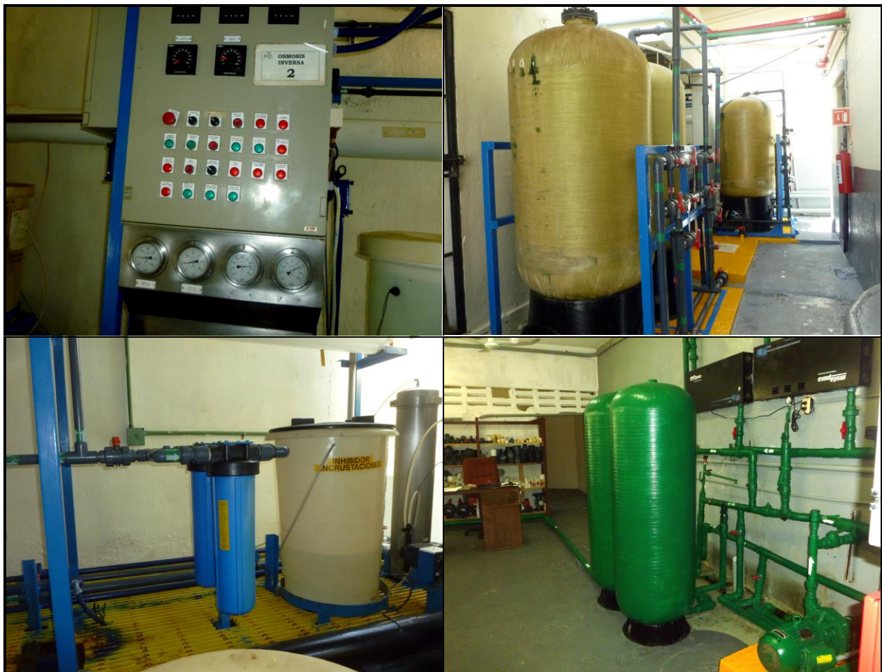
Distintos aspectos de los componentes de la planta de ósmosis inversa para la desalación de agua salobre con una capacidad total de 10 m 3 pd. La planta está diseñada para tratar agua con un contenido de salinidad de hasta 10,000 ppm de sales totales disueltas.
