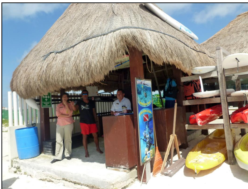
Palapa de actividades acuáticas, misma que se construyó sobre una rampa para embarcaciones, donde se prestan servicios para la renta de equipo acuático recreativo.
