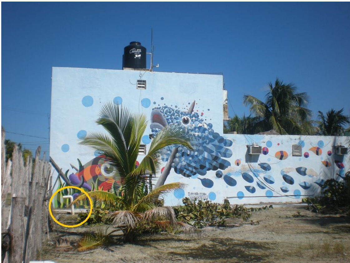
Fig. 6.- Conexión al drenaje sanitario de Isla holbox.
