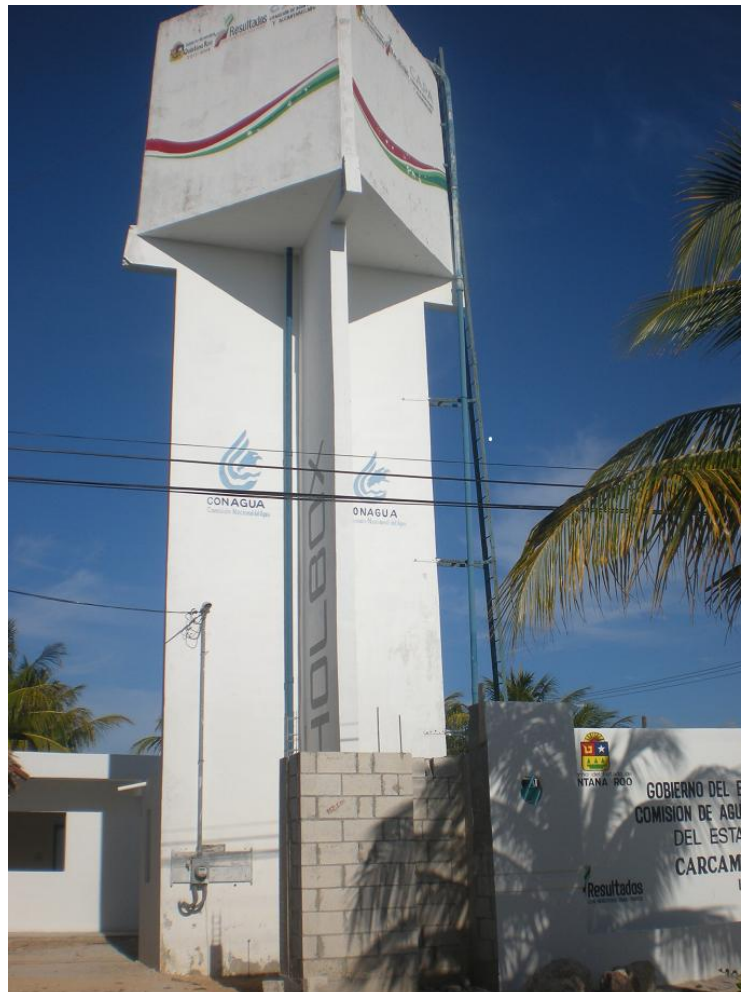
Fig. 21.- Cárcamo de agua potable CAPA Isla Holbox, Quintana Roo
