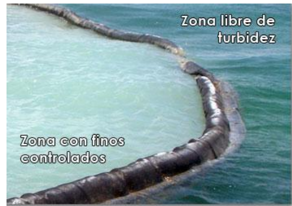
Finos en suspensión controlados con mallas anti dispersión
