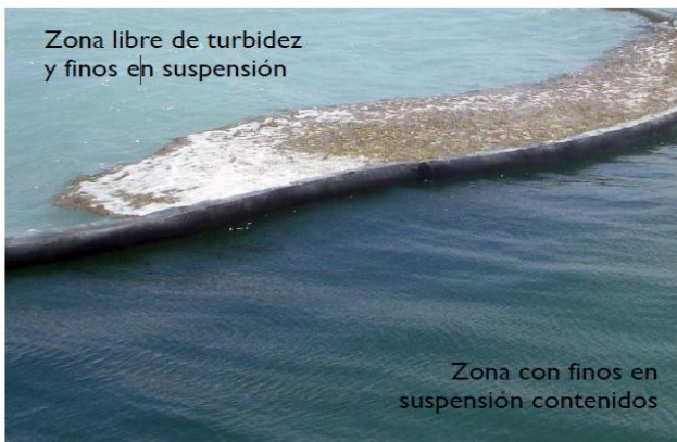
Situación típica en obras de dragado sin mallas anti dispersión
