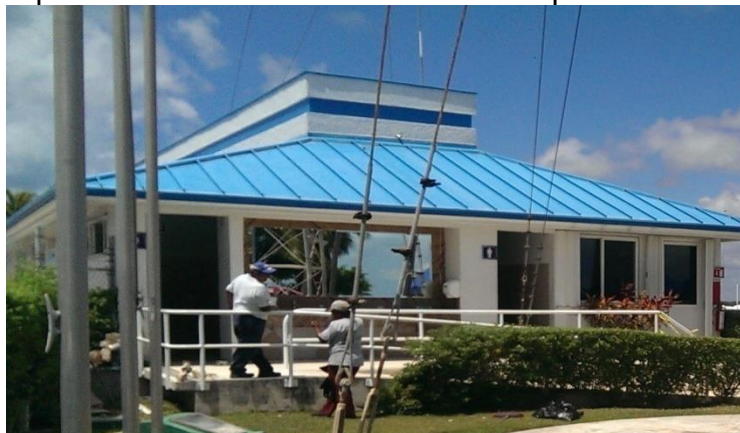
Imagen II.4-Baños disponibles para la etapa de construcción
