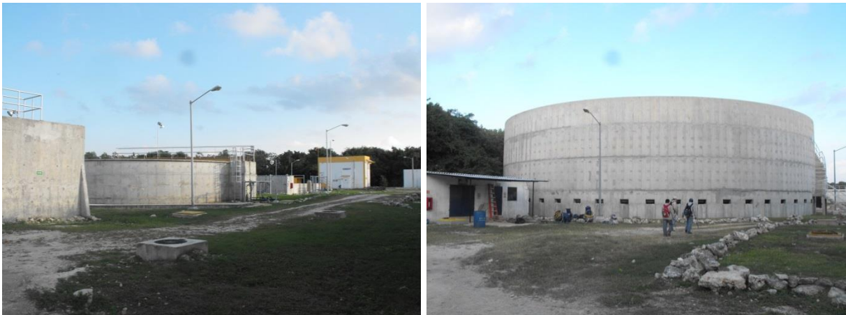
Figura 4.17.- Planta de tratamiento que opera en el predio.
