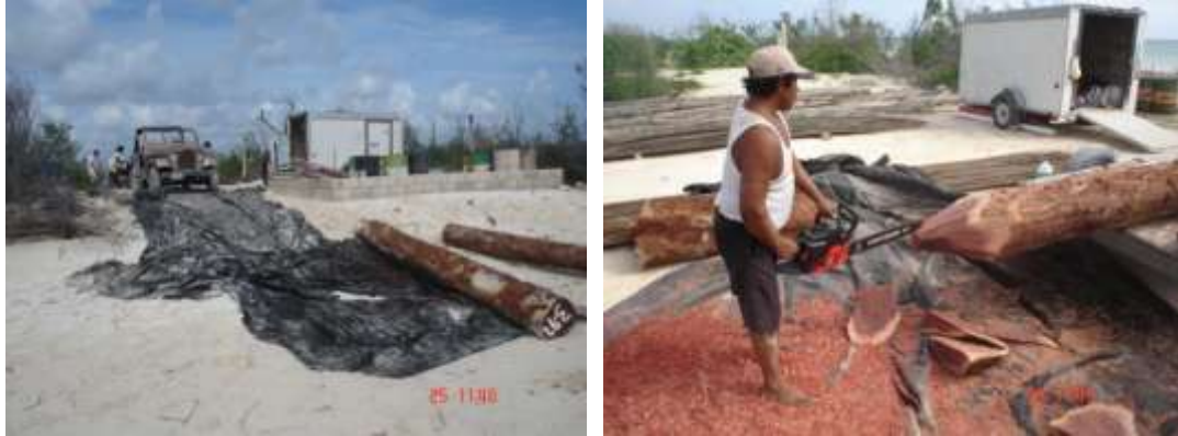
Figura 12. Previo al inicio de los trabajos en la zona marina se requiere el almacenamiento de la madera en la playa y su preparación.
