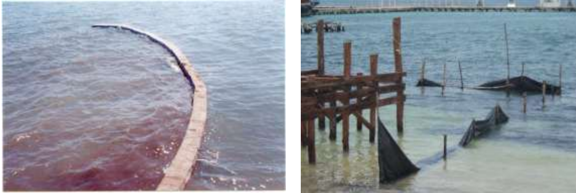
Figura 11. Para prevenir la dispersión de los sedimento, se habilitara una malla de geomenbrana.
