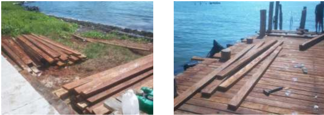
Figura 10. Se muestra el proceso entarimado o en tablado del atracadero.
