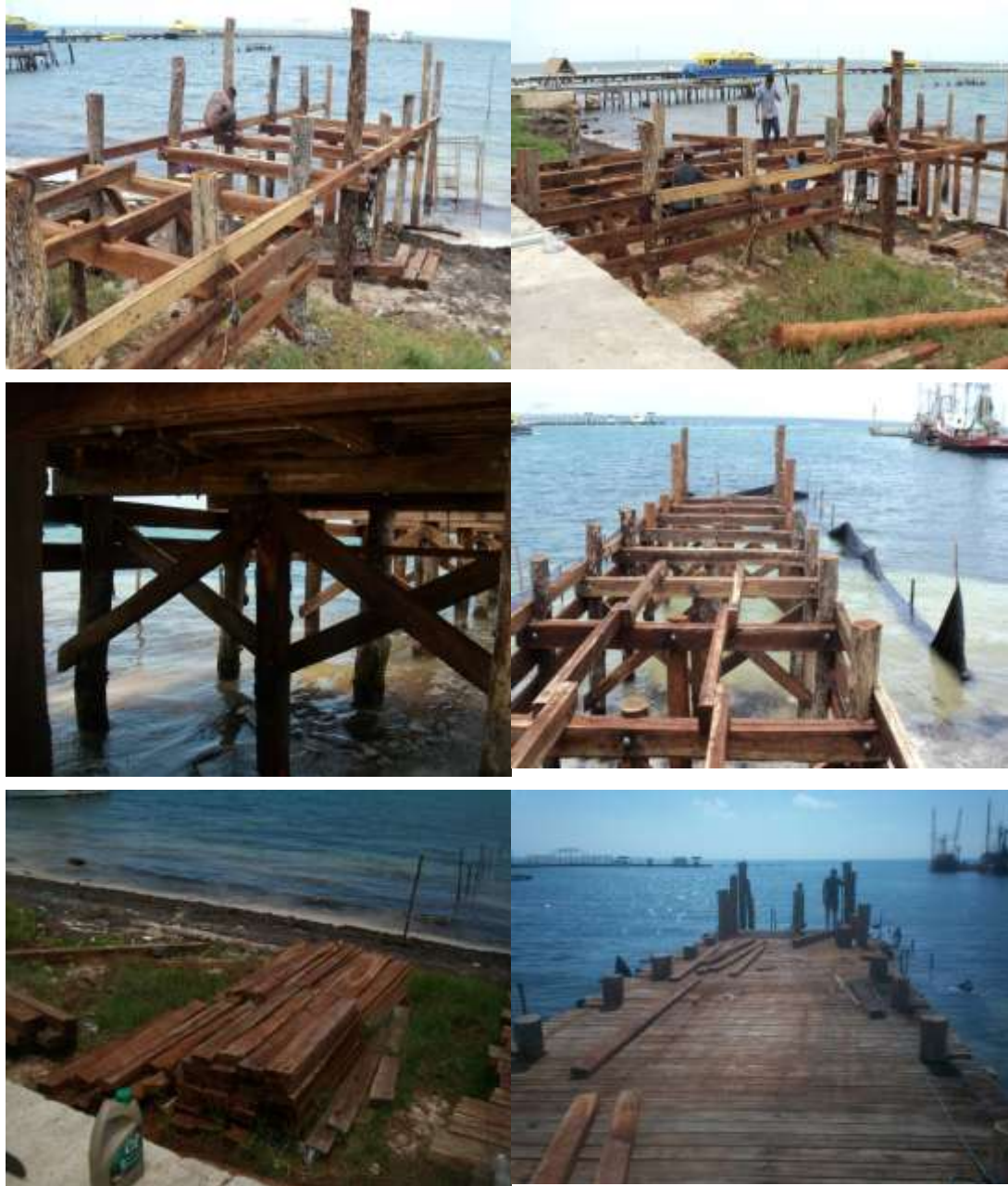
Figura 13. Las imágenes muestran algunos de los aspectos del proceso constructivo de la ampliación del atracadero rustico pesquero.
