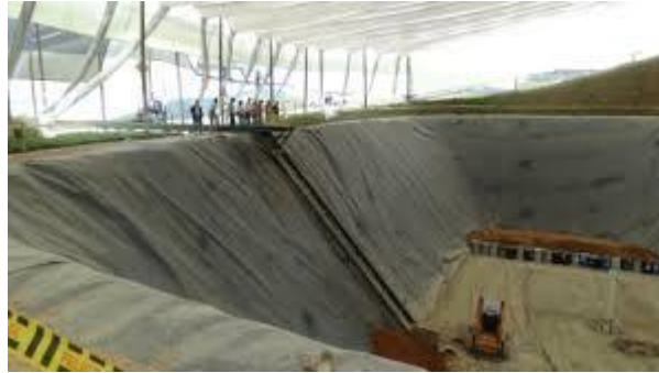
Figura VII.29 Ejemplo de confinamiento controlado.
