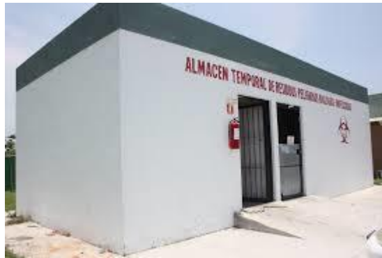
Figura VII.26 Almacén temporal de residuos peligrosos.
