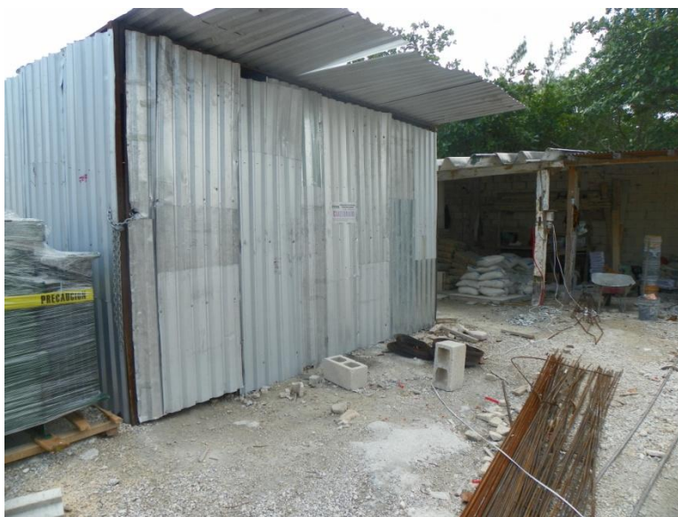
Figura II.8 Almacén temporal de materiales y equipos.
