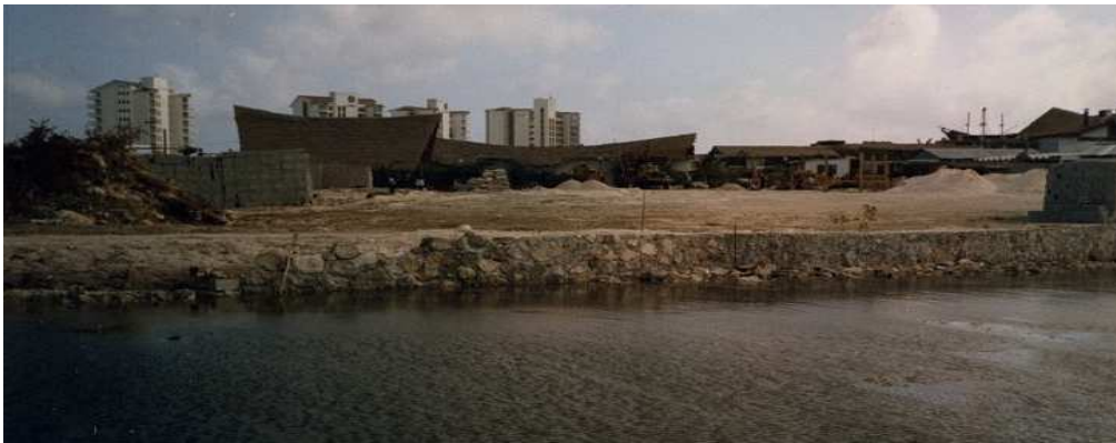
Figura 6. Se observa Zona Federal Marítimo Terrestre tal y como se encontraba cuando se adquirió el lote en mención, teniendo como limitante entre la ZOFEMAT y la Laguna Bojórquez el muro de contención.
