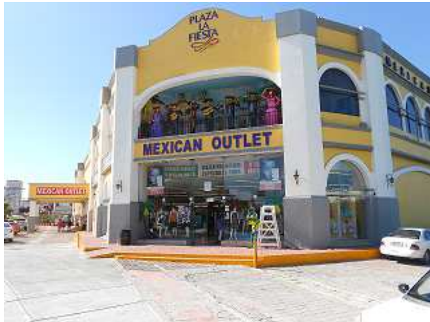
Figura 29. Plaza la Fiesta, colindante al área del proyecto, el cual forma parte integral de los servicios que brinda la plaza
