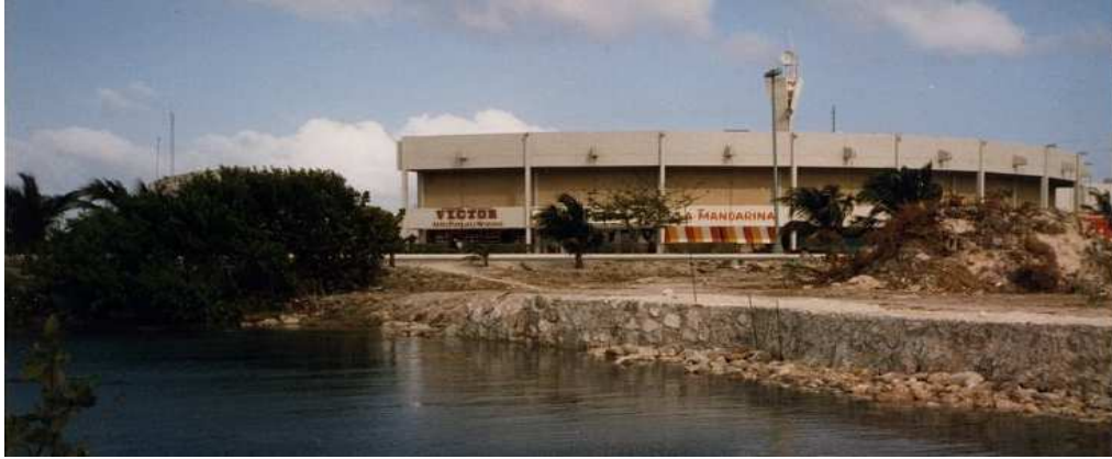
Figura 1. Imagen tomada en 1986, cuando se adquirió el lote antes mencionado, se observa muro de contención.
