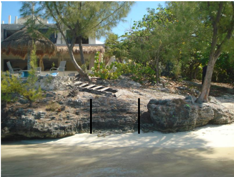
Figura 9.- Área de desplante del muelle en la zona federal colindante con el Lote 12.
