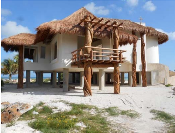
Figura 4. Casa similar a la programada (con pilotes y elevada), cerca al proyecto
