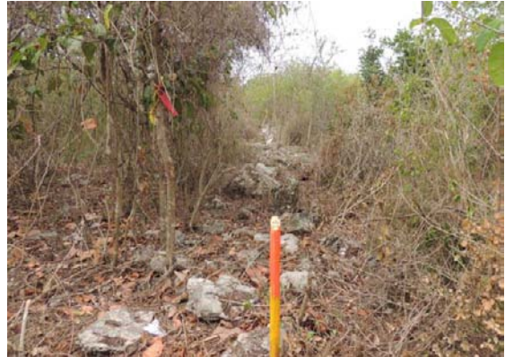
Foto 2.4 Trazo y delimitación física de las áreas de desmonte.
