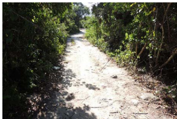
Foto 4.41 La zona desmontada y que se representa por un acceso existente a la zona de playa.
