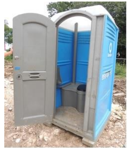
Foto 2.14 Los residuos sanitarios en la fase de construcción en letrinas portátiles.
