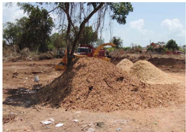
Foto 2.9 Vista del triturado del material del desmote
