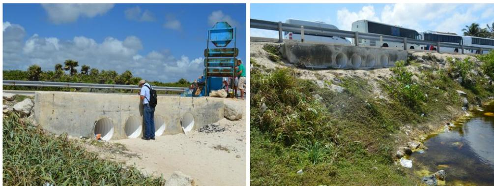
Figura 3a y 3b Efecto del relleno y nivelación de la carretera perimetral; izq. Lado oriente, der. Lado poniente, hay más de 2 metros de altura del nivel superficial del humedal.
