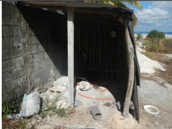
Acercamiento del interior de la bodega.
