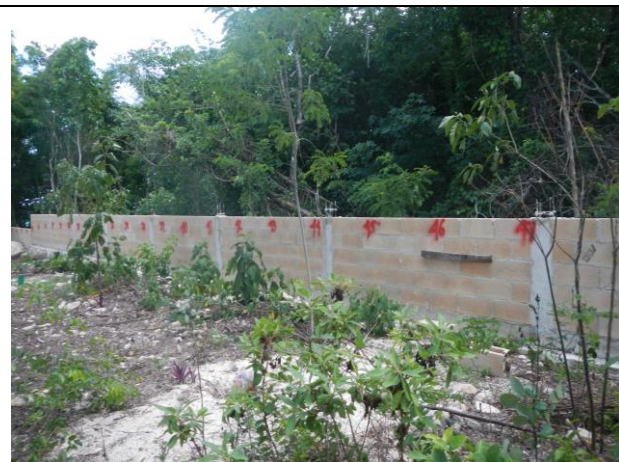
Barda construida en el lindero norte del predio.
