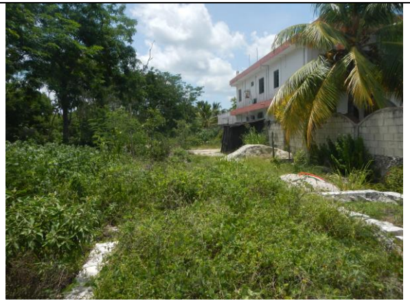
Vegetación secundaria colonizando la zona de cimentación existente.
