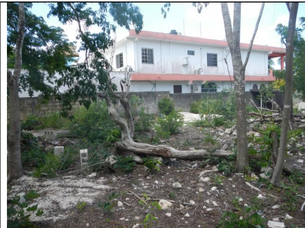
Barda perimetral del lindero sur del predio, esta barda fue construida por los dueños del terreno donde se observa el edificio de departamentos de color blanco.
