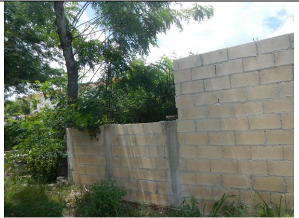
Barda del frente del predio.
