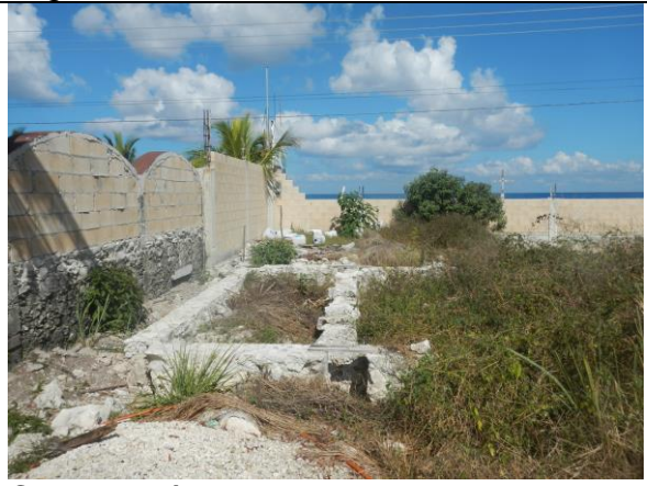
Cimentación existente, se observa la vegetación secundaria en su interior.
