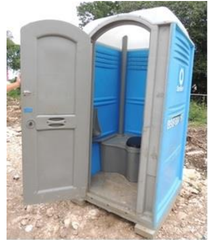
Foto 2.15 Los residuos sanitarios en la fase de construcción en letrinas portátiles.
