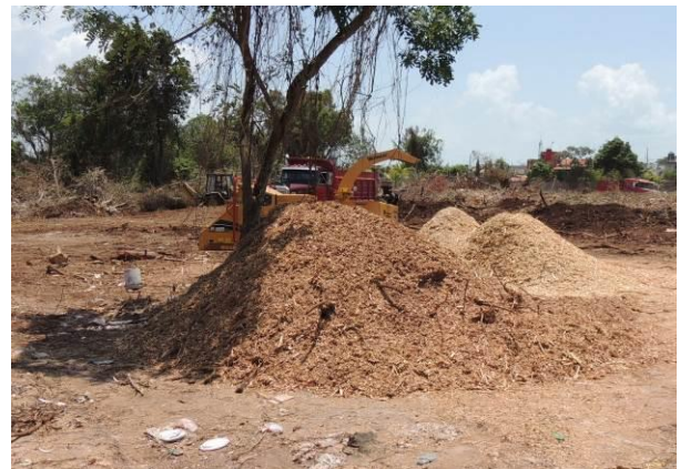
Foto 2.12 Vista del triturado del material del desmote
