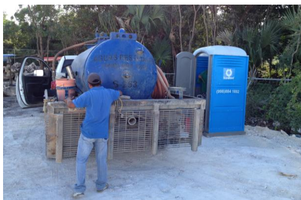
Foto 7.4 Durante la etapa de construcción se dará el manejo especializado en la generación de aguas residuales
