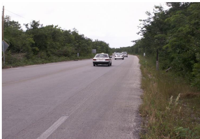
Foto 4.2 Vista de la Carretera Costera Sur con gran aforo vehicular aun en horas de la noche.
