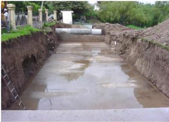
Excavación y plantilla
