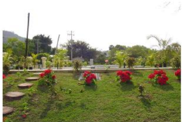
Vista lateral de la planta terminada
