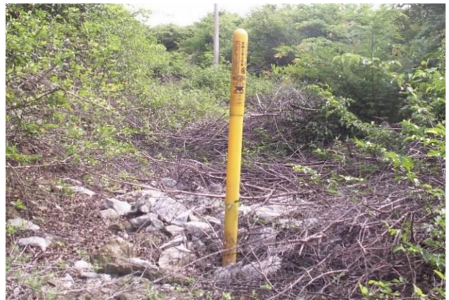
Foto 2.4 Servicio de telefonía existente en las inmediaciones del conjunto de predio.
