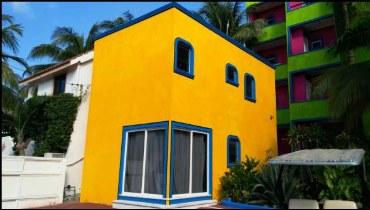
Figura II. 3. Edificio ubicado al Noroeste del proyecto consistente en bodega y condominio externo
