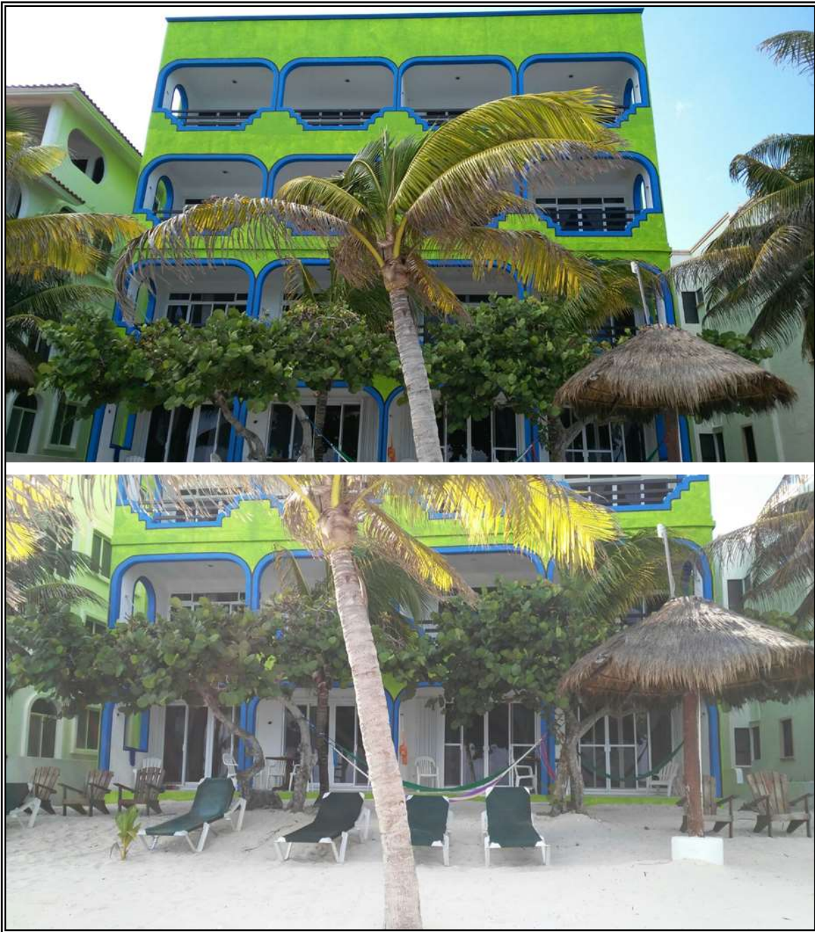
Figura II. 10. Obras e instalaciones localizadas al interior de los Terrenos Ganados al Mar.
