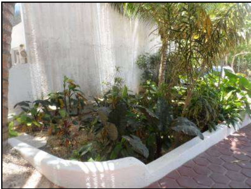
Figura II. 4. Estructura a manera de jardinera.
