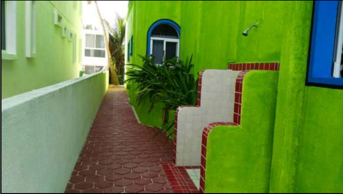
Figura II. 7. Pasillo construido con adocreto.
