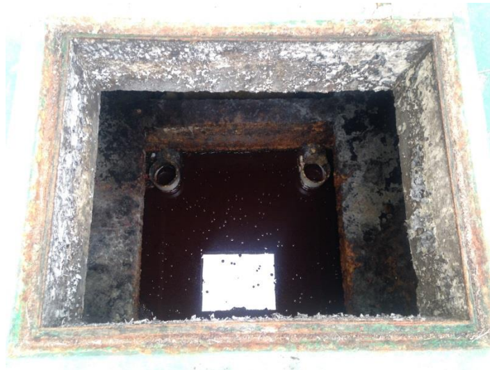
Figura 2.22. Imagen de una de las trampas de grasa del Proyecto.
