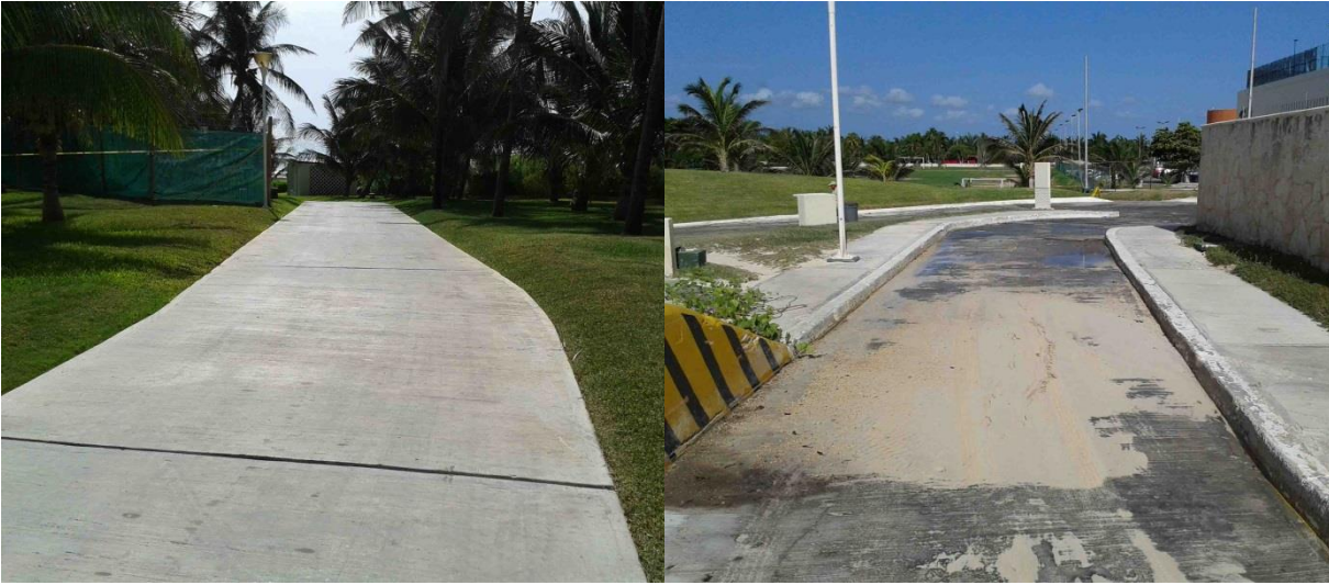
Figura 2.28. Imágenes de las vialidades de servicio del Proyecto.
