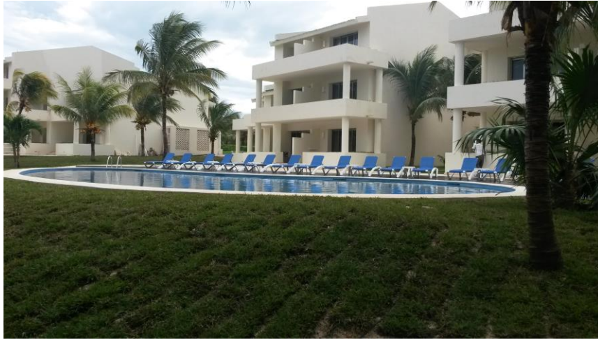
Figura 2.14. Imágenes de las villas en operación.
