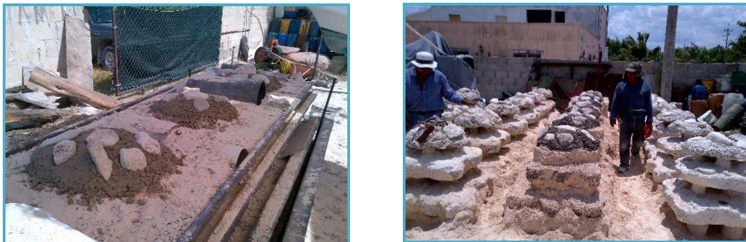
Figura II_ 38.- Fabricación de arrecifes en el patio de colado.
