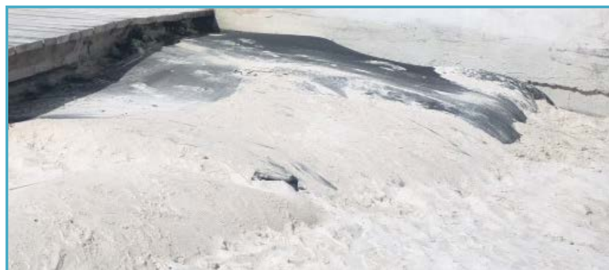
Figura II_ 22. Tubo de geotextil vacío y ejemplo de elemento de geotextil temporal de apoyo.
