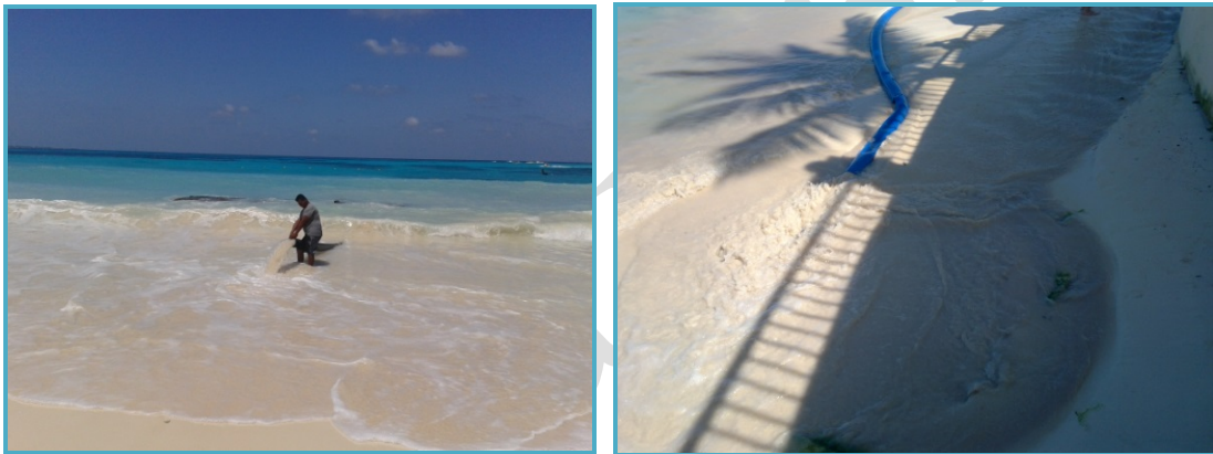
Figura II_ 32. Colocación de tuberías para el transporte de arena.
