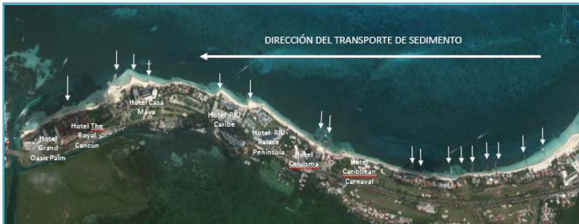
Figura II_ 2. Se muestran las diversas estructuras que atrapan la arena y no permiten que llegue a depositarse en el área del proyecto.
