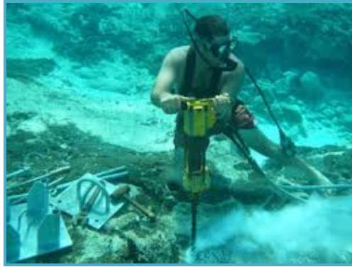
Figura II_ 42.- Ejemplo de perforación del sustrato para anclas tipo stingray
