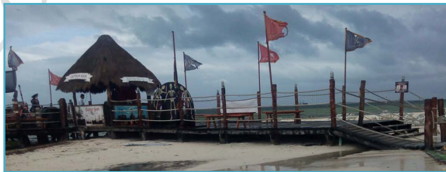
Figura II_8. Muelle principal de la marina existente.
