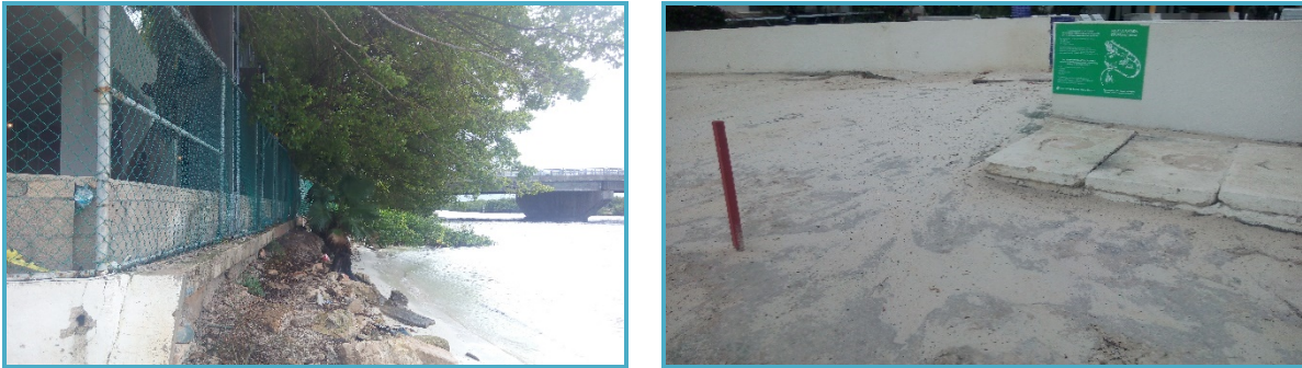
Figura II_ 6. Fotografías de la afectación por pérdida de playa en el área del proyecto.
