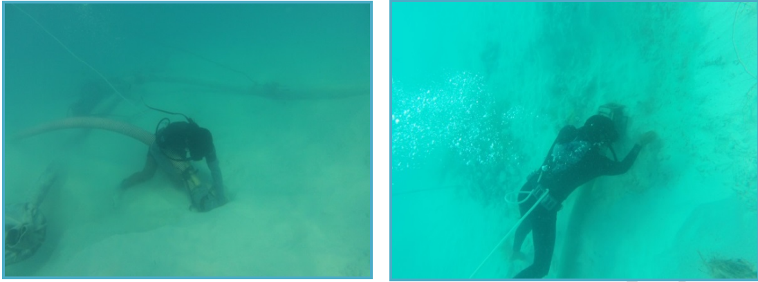
Figura II_ 33. Colocación de tuberías y mangueras para el transporte de arena.
