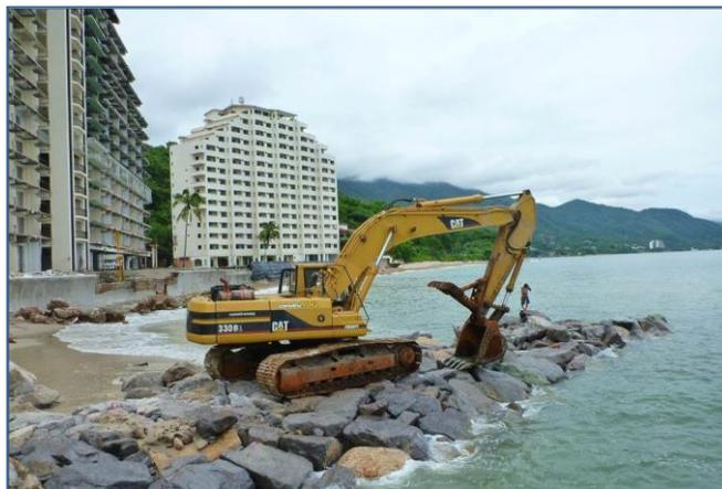
Figura 52. Excavadora construyendo piedraplén hasta alcanzar el eje de los arrecifes artificiales.
